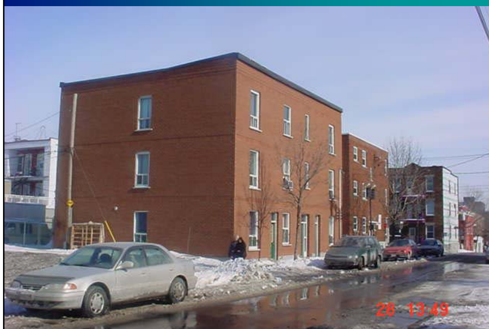
Côté sud-est de la rue Joliette.
