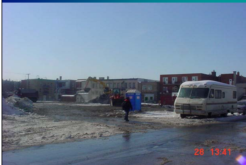
Site Lavo côté ouest de la rue Nicolet.
