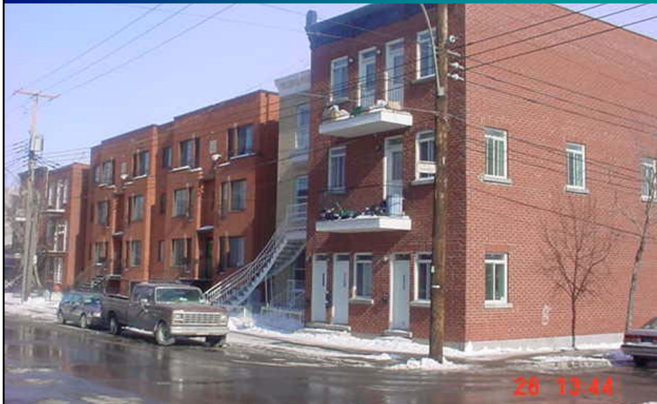
Côté sud-est des rues de Chambly et La Fontaine.
