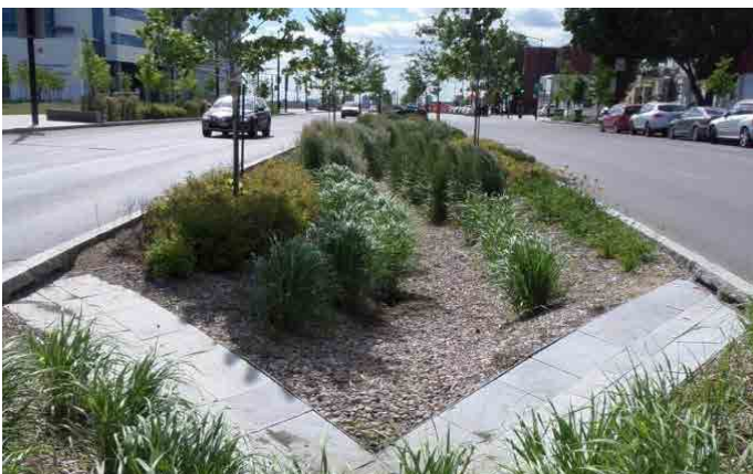
Exemple de bassin drainant en terre-plein central
