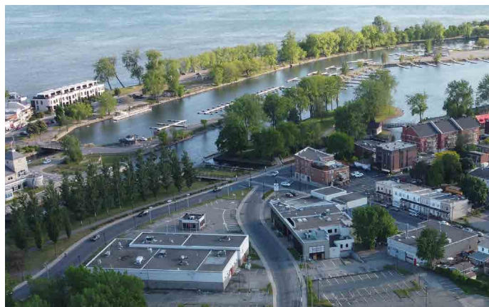
Vue aérienne du seuil Sud-Ouest
