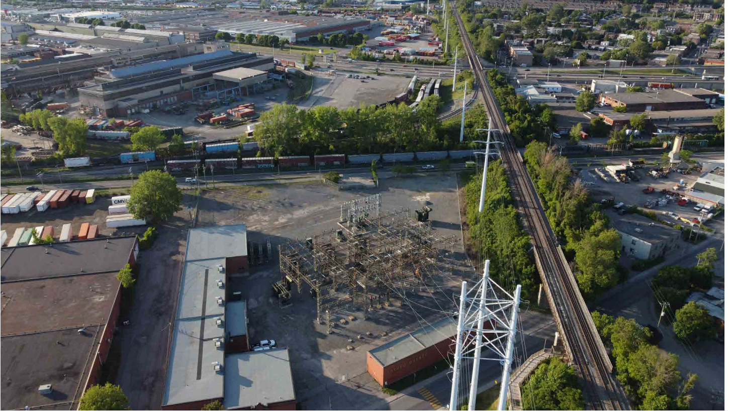
Vue aérienne du poste d'Hydro-Québec
