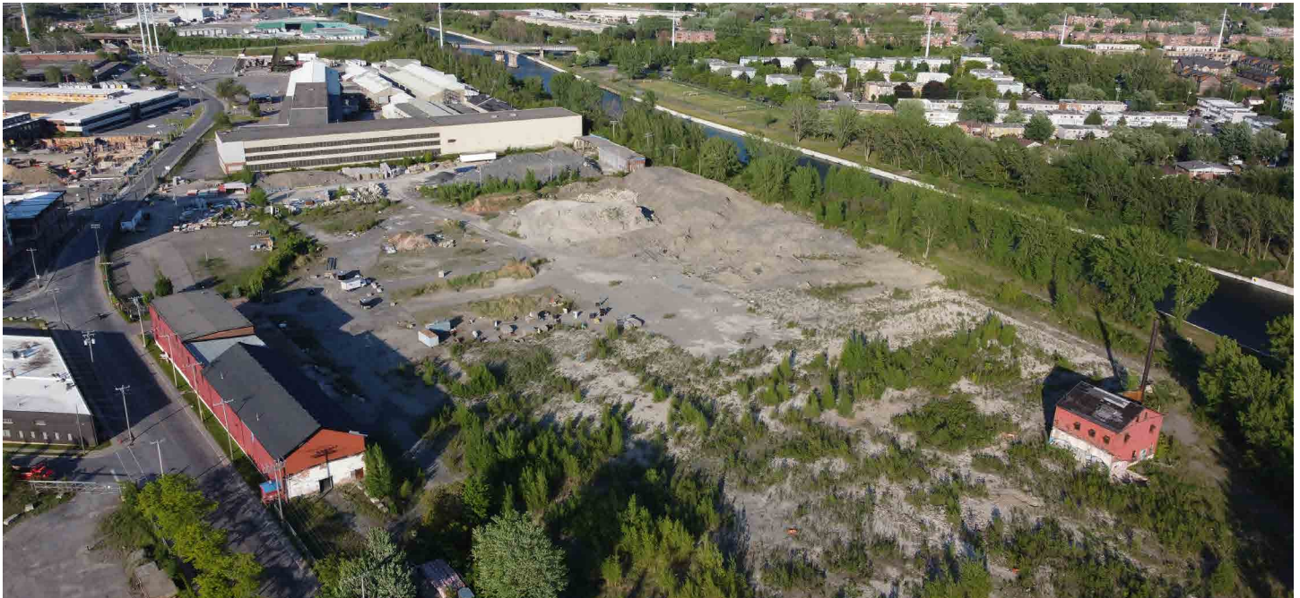
Vue aérienne du site vacant de la Stelfil
