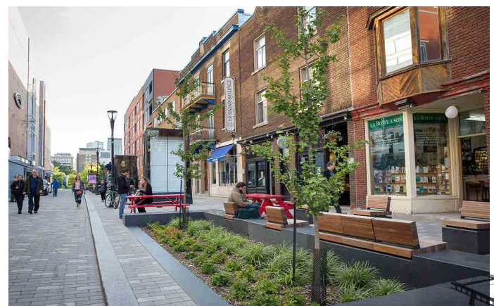
Exemple de noue drainante et de mobilier urbain
