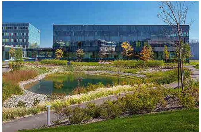
Exemple de bassin de rétention
