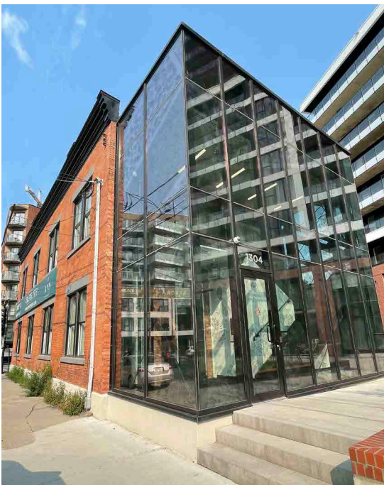
Agrandissement respectant le patrimoine bâti
