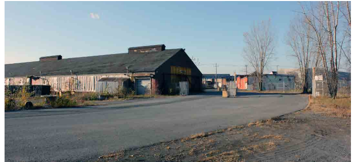
Photo des halles de la Cintube
