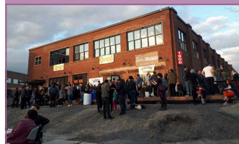
Occupation transitoire du bâtiment K
