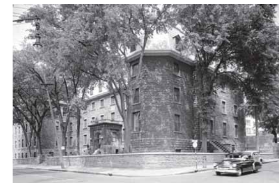
L'Hôpital général rue Saint-Hubert en 1952. Photo : Pierre Deléan.
