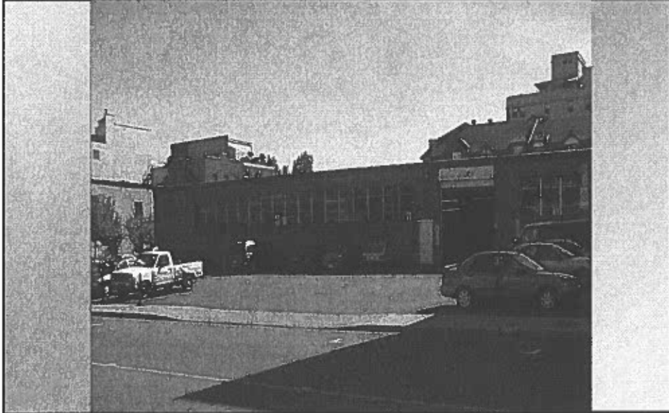
Bâtiment semi-industriel existant rue Amherst (à démolir)
