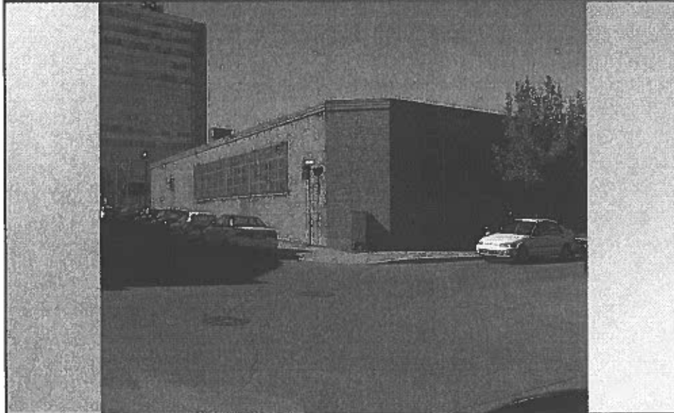
Bâtiment semi-industriel existant La Gauchetière/St-Thimothée (à démolir)
