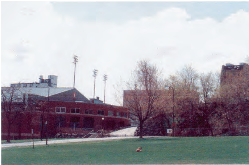
Vue du Stade Molson existant (gradins sud) et le stade R.H. Tomlinson.
