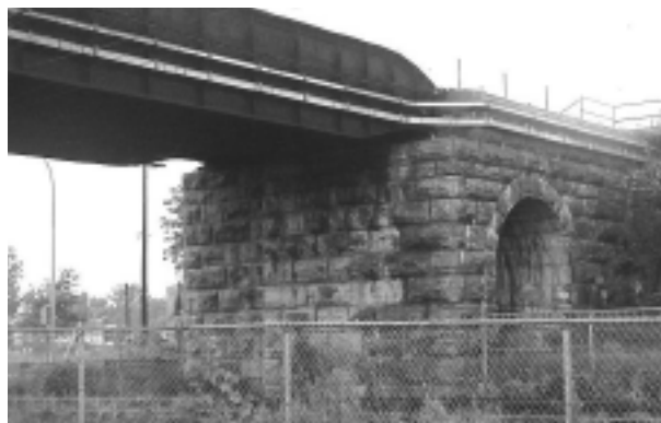
19.N.1 Un pont ferroviaire du pôle industriel
