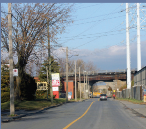
Pont ferroviaire du Canadien Pacifique
