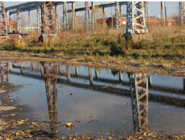
Ponts roulants-Dominion Bridge
