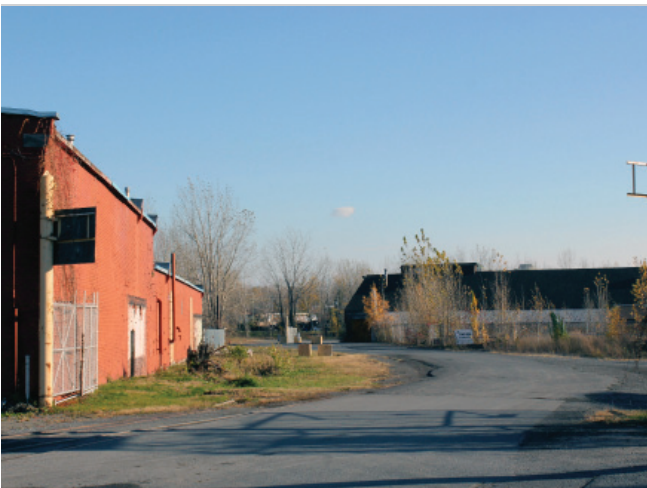
Vue de la Cintube vers le canal de Lachine
