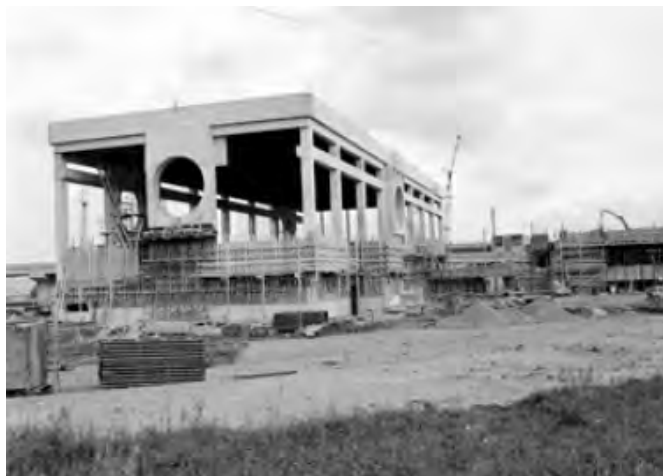
Construction du poste Viger, 1980 («Histoires d'Hydro-Québec – Le poste Viger», HydroPresse, 29 février 2016)
