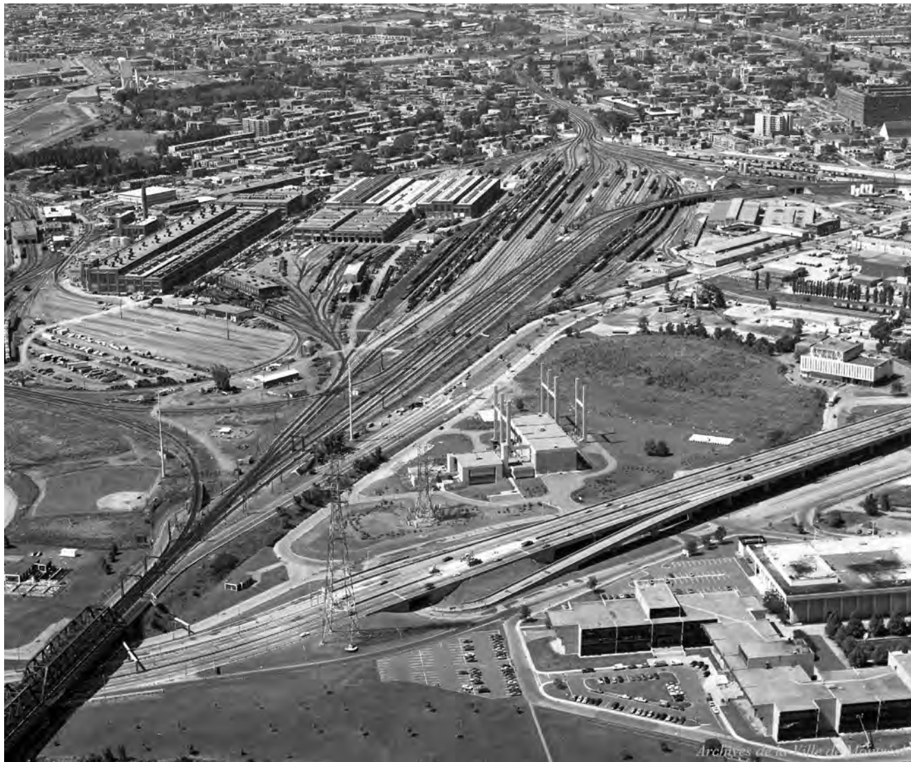
Poste Viger et ateliers du CN, 1985 (Réjean Martel - Archives Ville de Montréal)
