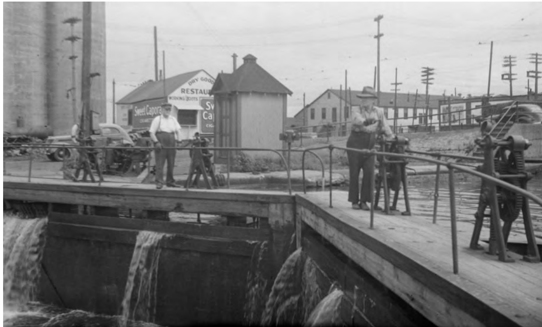
Mécanisme manuel d'ouverture des écluses, 1948 (Conrad Poirier - BANQ)
