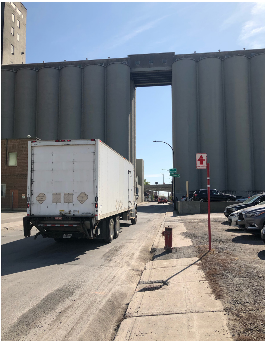
Camionnage sur la rue Mill © ADM, 2019.
