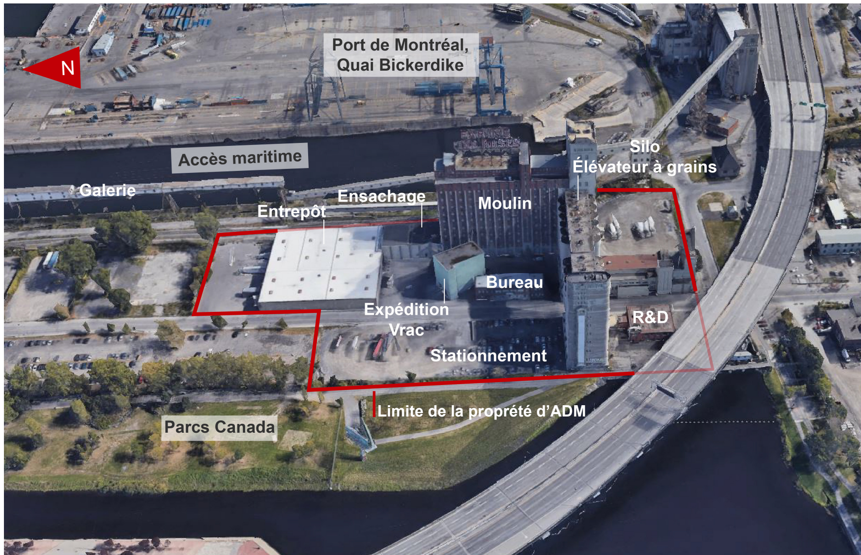
Complexe industriel d'ADM © Google Earth, 2019. Traitement : ADM, 2019.
