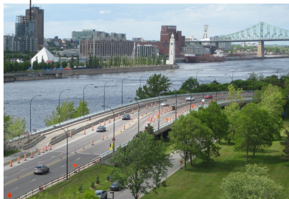
Sortie nord de la Cité du Havre vers le pont Jacques-Cartier. Photo : Lucette Lupien
