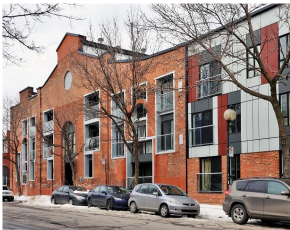
Architecture : Aedifica Crédit photo : Denis Tremblay
