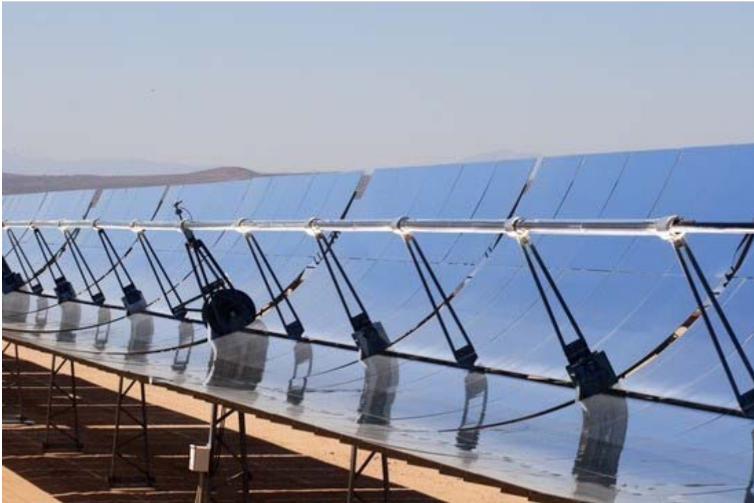
Panneau à chauffage solaire réfléchissant (crédit photo SEIA.org)
