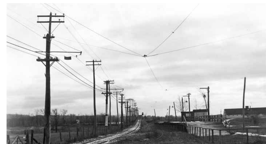
Fig. 59 : Ligne de tramway Cartierville et quai de débarquement, 1921. Source : Archives de la Société de transport de Montréal, 2-920-049 - 1921.
