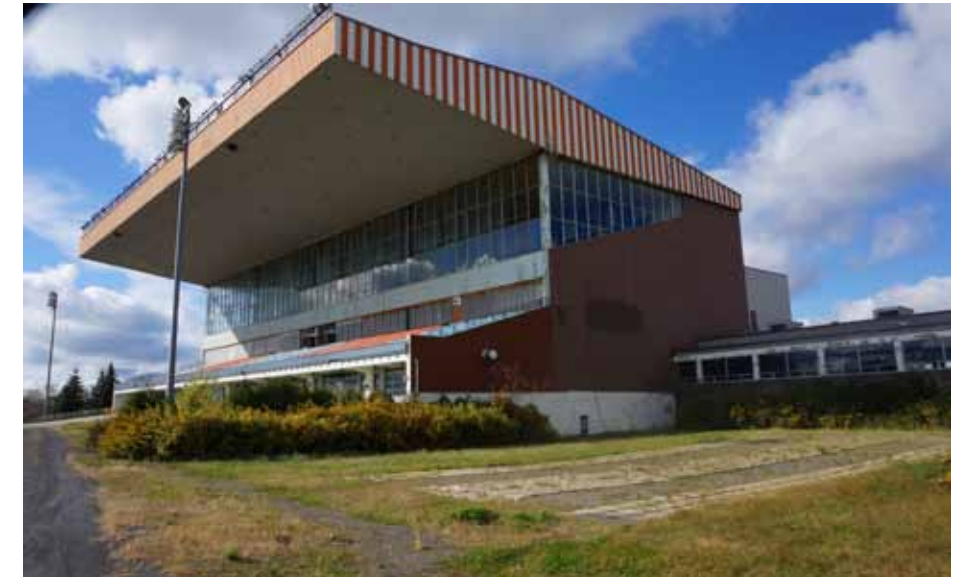
Fig. 83 : Club-house, façade latérale.
