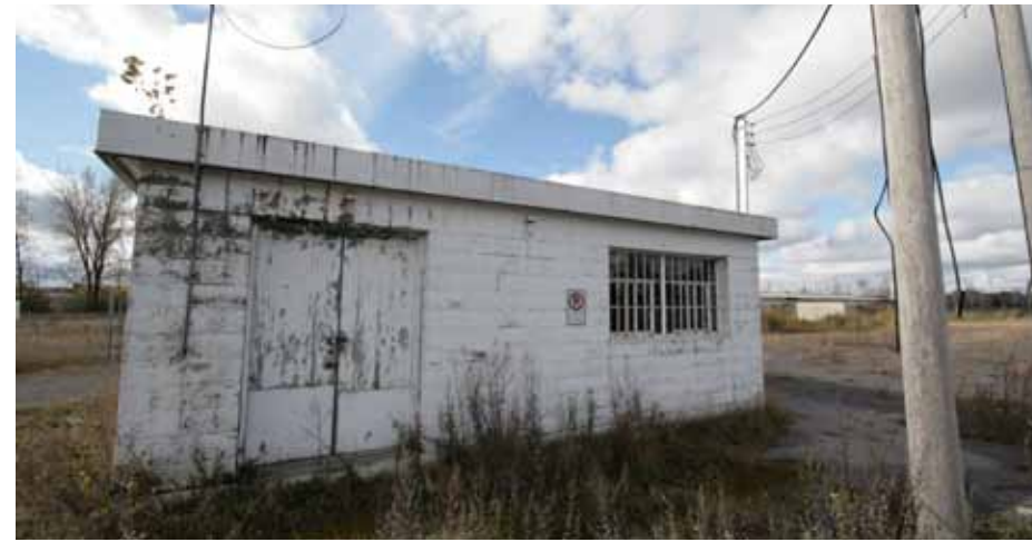
Fig. 110 : Bâtiment des pompes.
