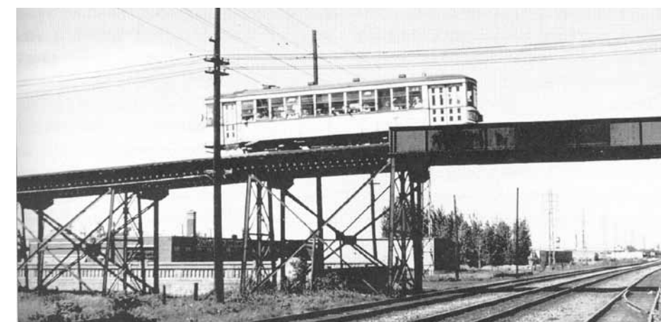
Fig. 60 : Pont à chevalets de la ligne Cartierville au-dessus du chemin de fer du CP, date inconnue. Source : Jacques, PHARAND, À la belle époque des tramways : un voyage nostalgique dans le passé, Montréal, Éditions de l'Homme, 1997, p. 67
