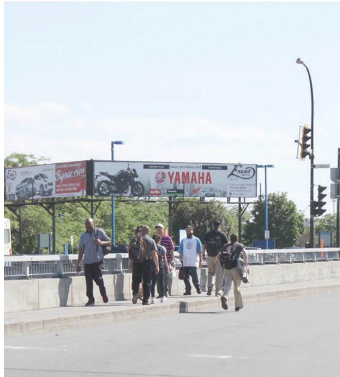
E - Vue du trottoir sud du viaduc Des Jockeys. Un piéton dépasse un groupe en utilisant la chaussée puisque la largeur du trottoir ne suffit pas.
