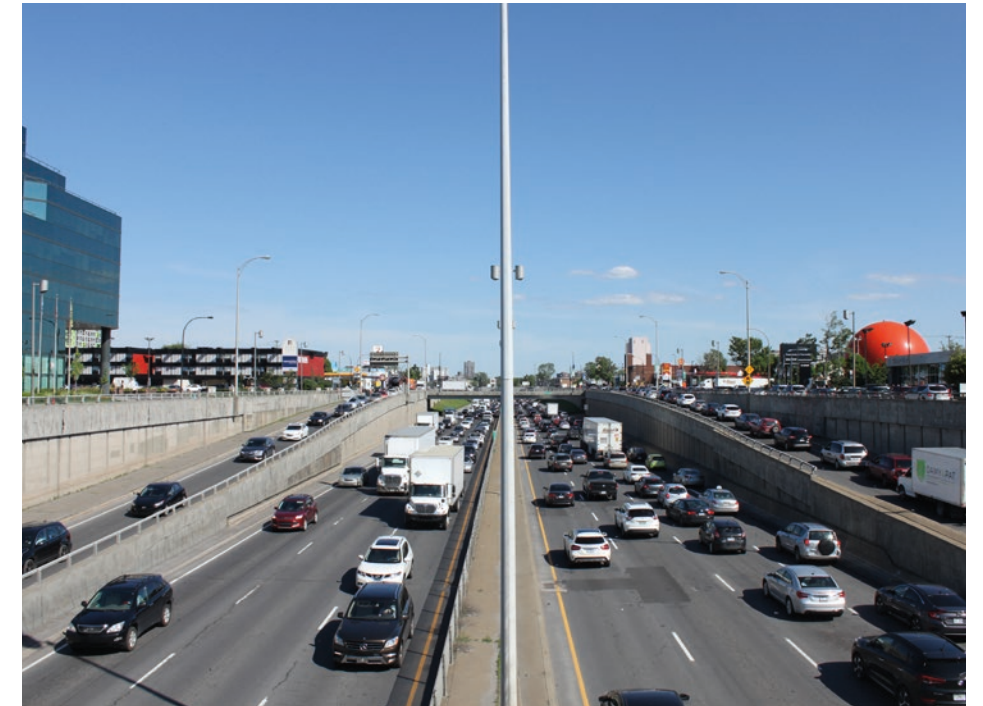
Vue vers le sud de l'autoroute Décarie à partir de la rue Ferrier. La circulation est dense dans toutes les directions ainsi qu'aux entrées et sorties. À cet endroit, un véhicule empruntant la sortie 69 et se dirigeant vers l'ouest doit poursuivre sa route plus au sud jusqu'à la rue Des Jockeys.
