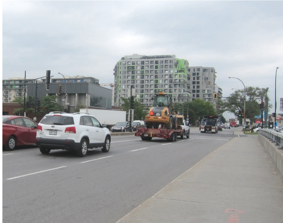
A - Trottoir sud du viaduc Jean-Talon très étroit, peu protégé de l'autoroute et sans aménagement ni mobilier.
