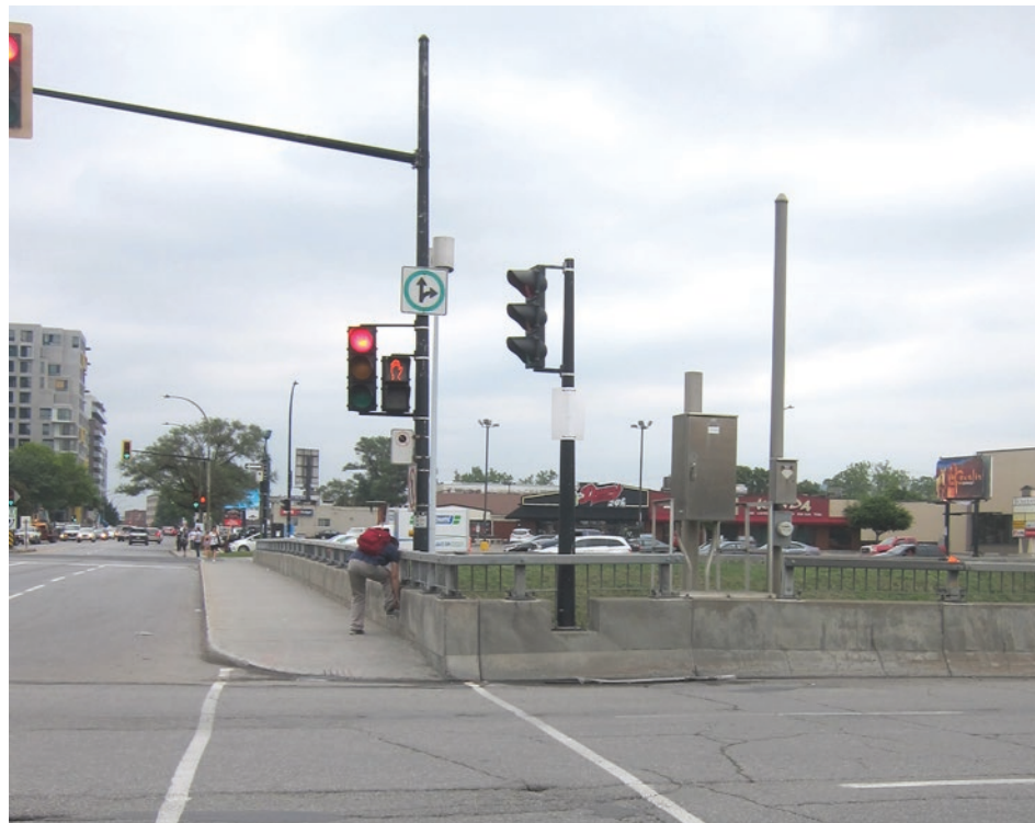
B - Vue vers le trottoir sud du viaduc Jean-Talon, l'espace disponible pour les piétons est disproportionné en comparaison avec l'espace donné aux circulations véhiculaires.
