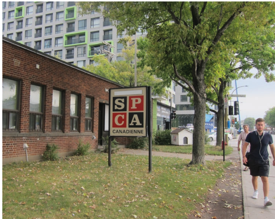
I - Vue du trottoir nord sur Jean-Talon près de l'avenue Mountain Sights. Le gazon est piétiné sur l'emprise du trottoir nord de Jean-Talon démontrant l'étroitesse des trottoirs dans un secteur avec forte densité de circulation piétonne.
