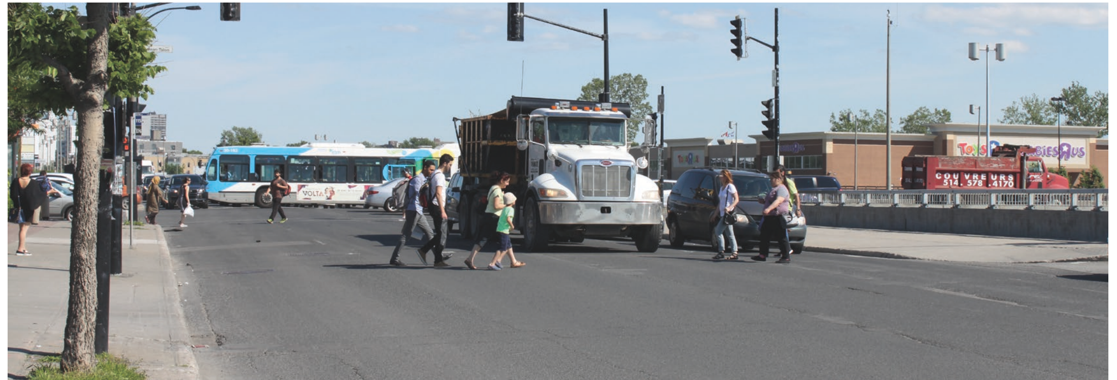
M- Vue vers le nord à partir du carrefour est du viaduc des Jockeys. Les piétons traversent les quatre voies à l'intersection. Le marquage de rue est très peu visible.
