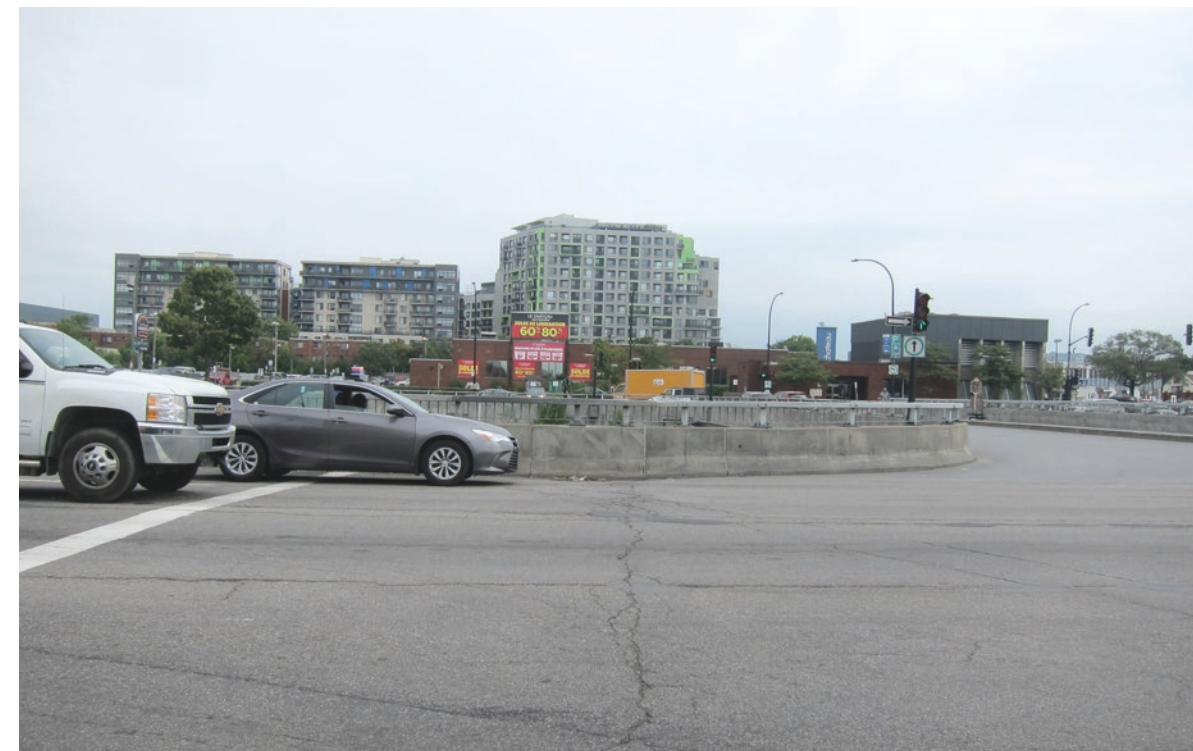
F - Vue vers le viaduc Des Jockeys à l'intersection des Jockeys et du boulevard Décarie. Il n'y a pas de traverses piétonnes ni de trottoir sur le côté nord du viaduc. Certains piétons tentent de traverser à ce carrefour.
