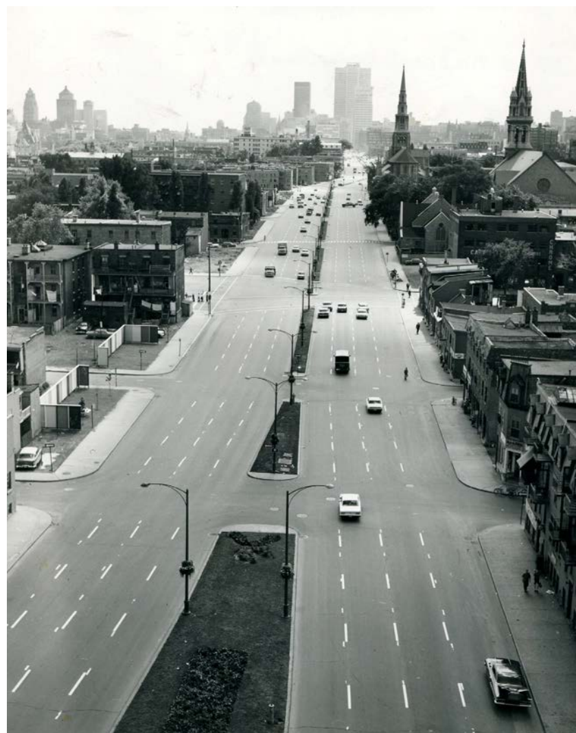
Vue vers l'ouest en 1955. Les traces de l'ancien boulevard Dorchester sont visibles à droite de la tranchée engendrée par les travaux de démolition menés lors de son élargissement. Source : Tirée de Montreal Then and Now, p. 79.
