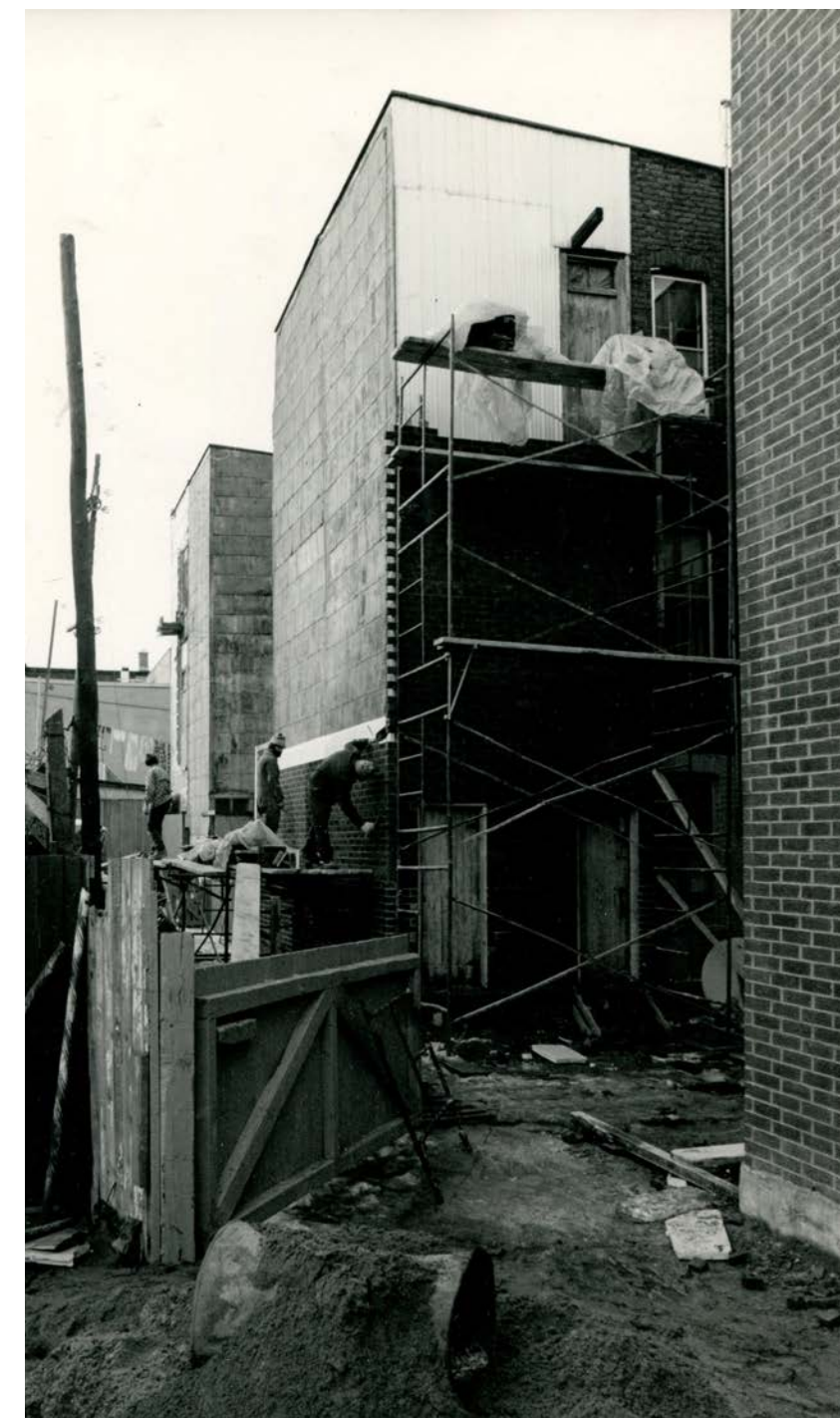
Bâtiment en rénovation. Date inconnue. Source : Collection de l'Écomusée du fier monde.
