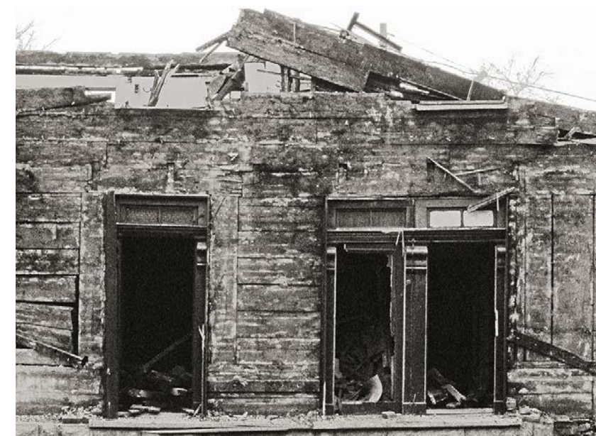
Démolition du 1780, rue Montcalm, vers 1975. Source : Daniel Heikalo.
