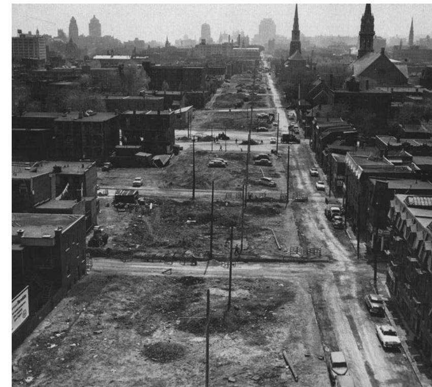
Vue vers l'ouest en 1955. Les traces de l'ancien boulevard Dorchester sont visibles à droite de la tranchée engendrée par les travaux de démolition menés lors de son élargissement.
