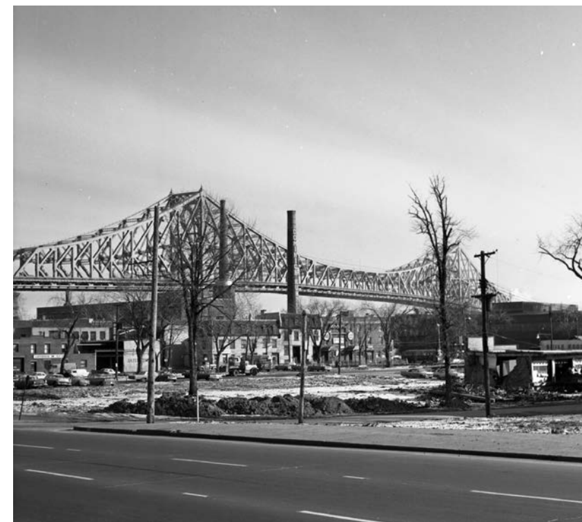
La démolition du faubourg à m'lasse, vers 1963. Source : Archives de la Ville de Montréal, VM94-C290-006.
