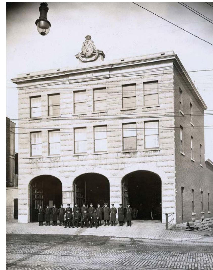
Troisième caserne n°7 en 1910, sur la rue Notre-Dame Est. On remarque notamment que les niveaux de l'édifice sont organisés selon la topographie. Source : Archives Service des incendies de Montréal.
