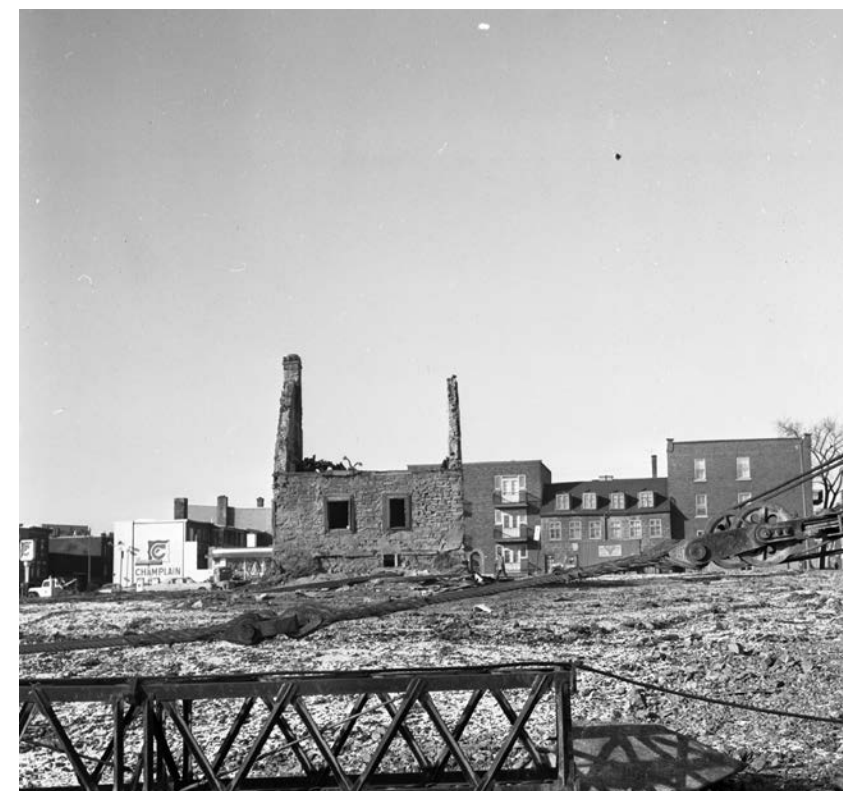
La démolition du faubourg à m'lasse, vers 1963. Source : Archives de la Ville de Montréal, VM94-C290-036.
