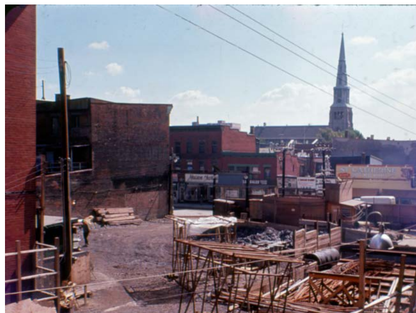
Construction de la station Beaudry sur un terrain qui était vacant au moment de la construction du réseau initial. Entre 1964 et 1966. Source : Archives STM. S10 10.1.17,1-1.
