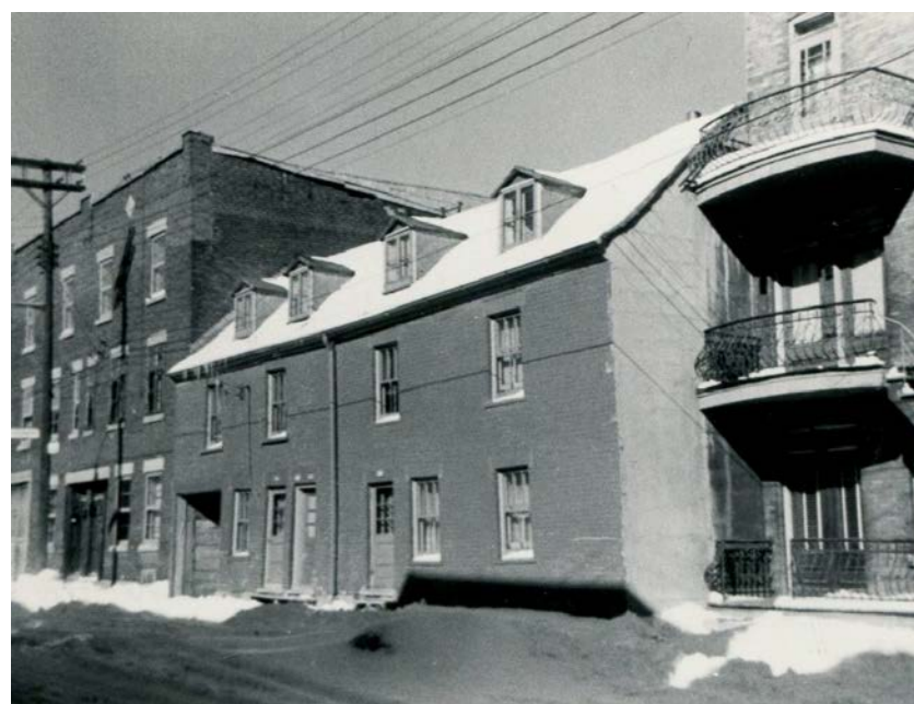
Trois plex issus de périodes de construction différentes. Au centre, le plus ancien avec un toit à pignon et des fenêtres en lucarne. À gauche, un modèle à trois étages à toit plat, et à droite un plex un peu plus récent avec une marge de recul significativement plus grande et avec des balcons et des escaliers extérieurs. Source : Collection de l'Écomusée du fier monde.
