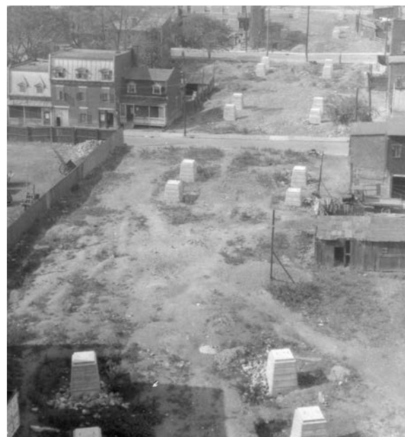
Vue vers le nord montrant des ancrages en béton pour les piliers dans l'axe de l'avenue De Lorimier, à droite sur la photo.
