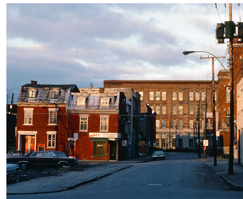
Vue prise de la rue Robin à l'angle de la rue Wolfe, vers l'est, vers 1974. On remarque des têtes d'îlots démolies. Source : Daniel Heikalo.
