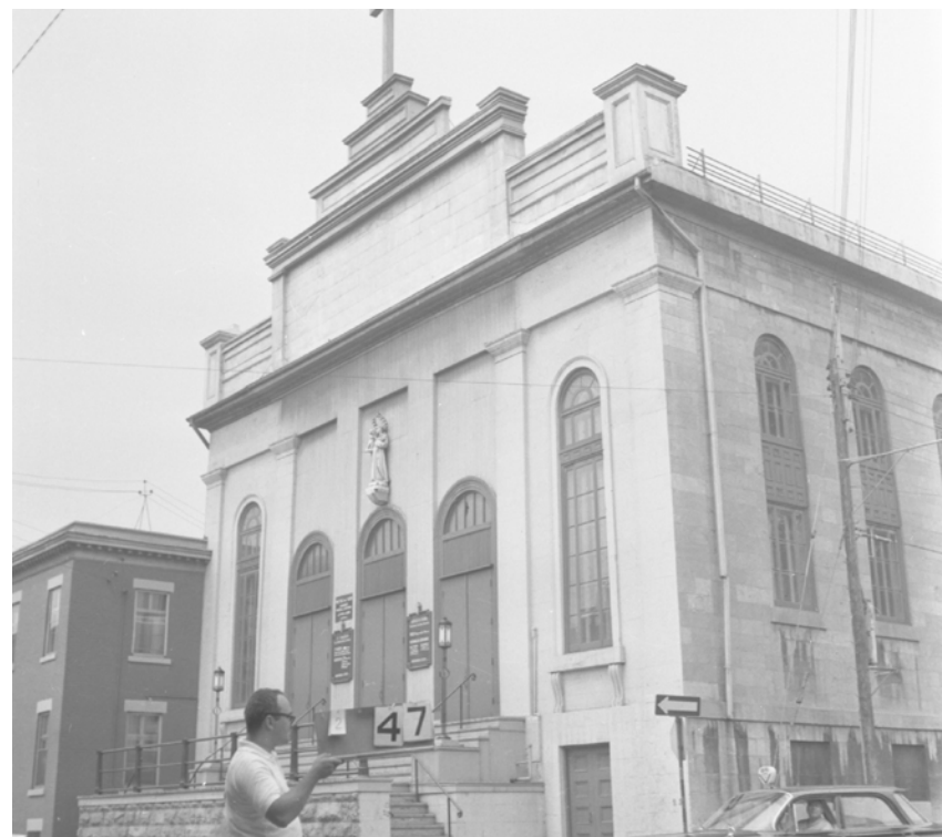
La chapelle Saint-Antoine, située sur la rue Plessis, qui sera démolie dans le cadre du projet de Radio-Canada, vers 1963. Source : Archives de la Ville de Montréal.
