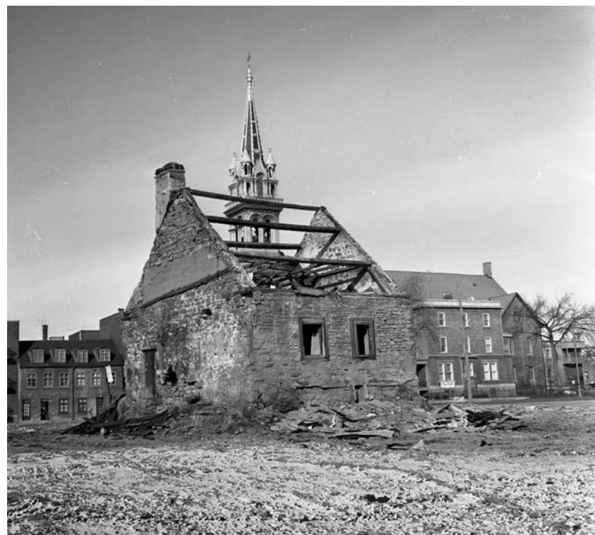
La maison Hubert-Lacroix pendant la démolition du site de Radio-Canada, vers 1963. Source : Archives de la Ville de Montréal, VM94-C290-002.
