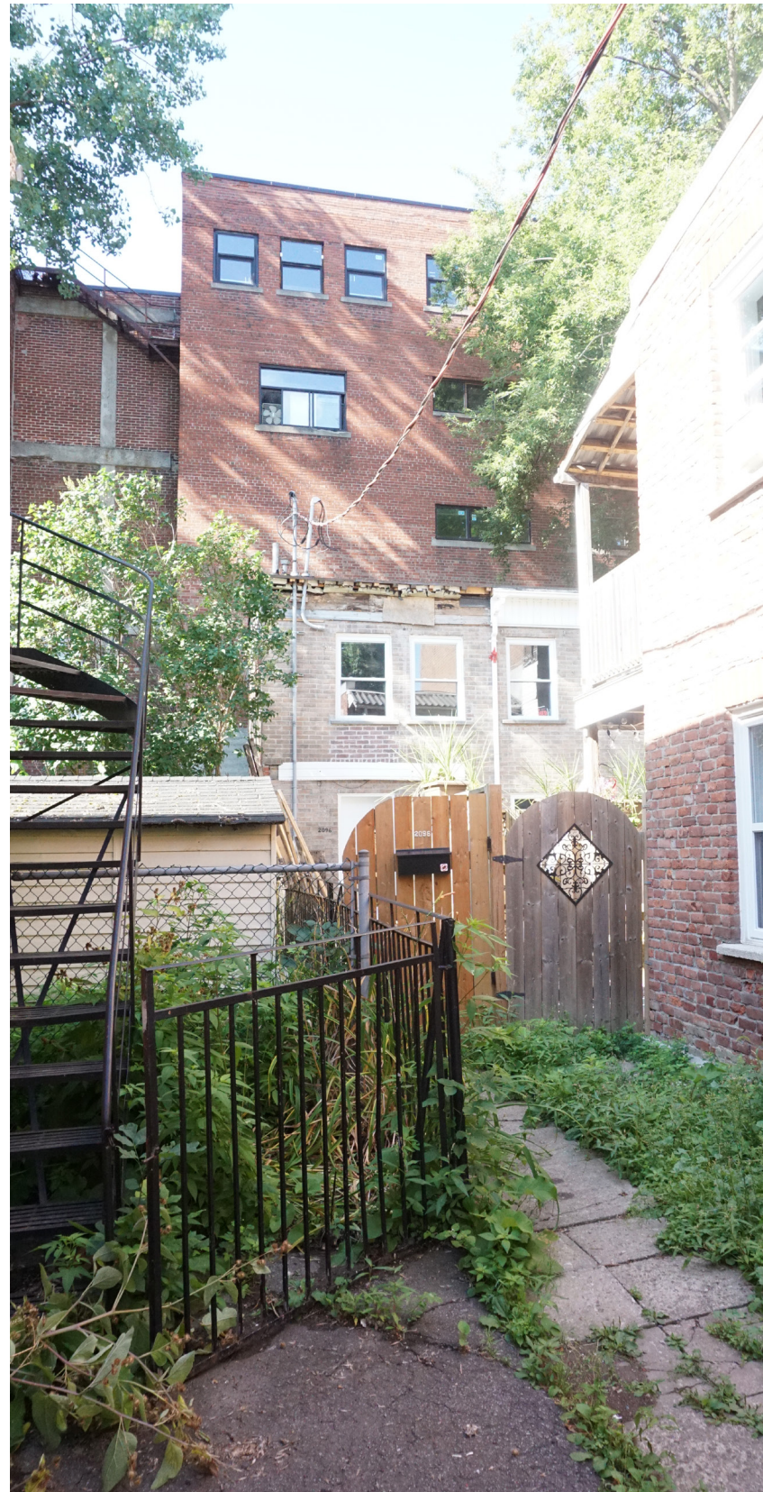
Bâtiment de fond de cour situé sur la rue Harmony
