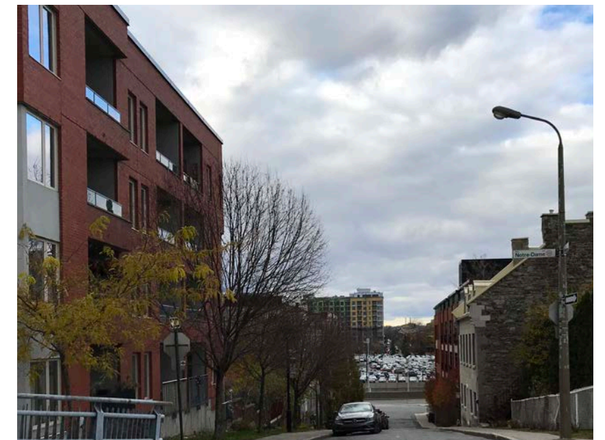
Des condominiums ont été construits aux abords de la maison traditionnelle urbaine Marguerite-Hay sur la rue Montcalm
