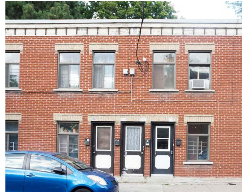
Plex de première génération sur la rue Montcalm
