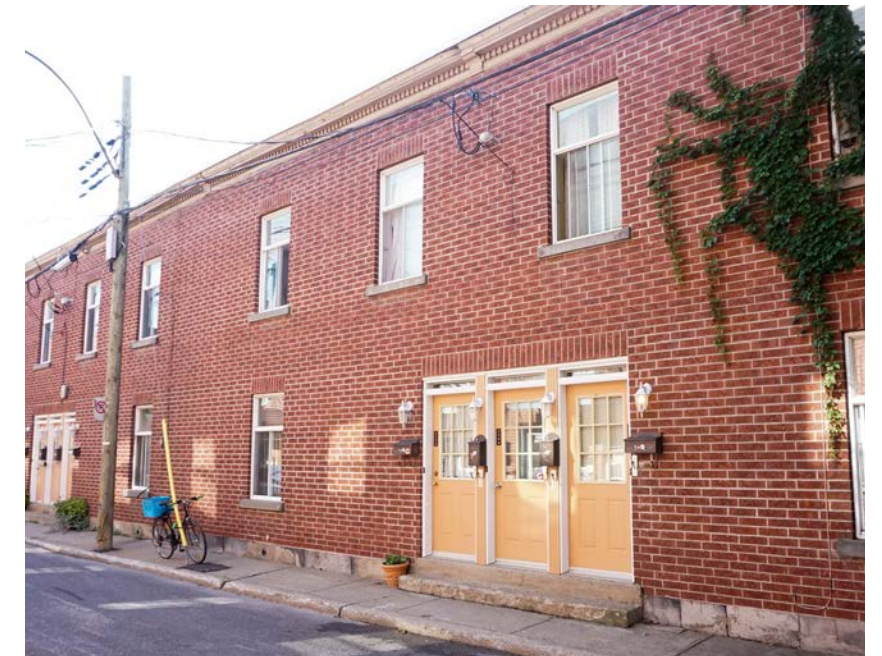
Plex de première génération sur la rue Prince-George
