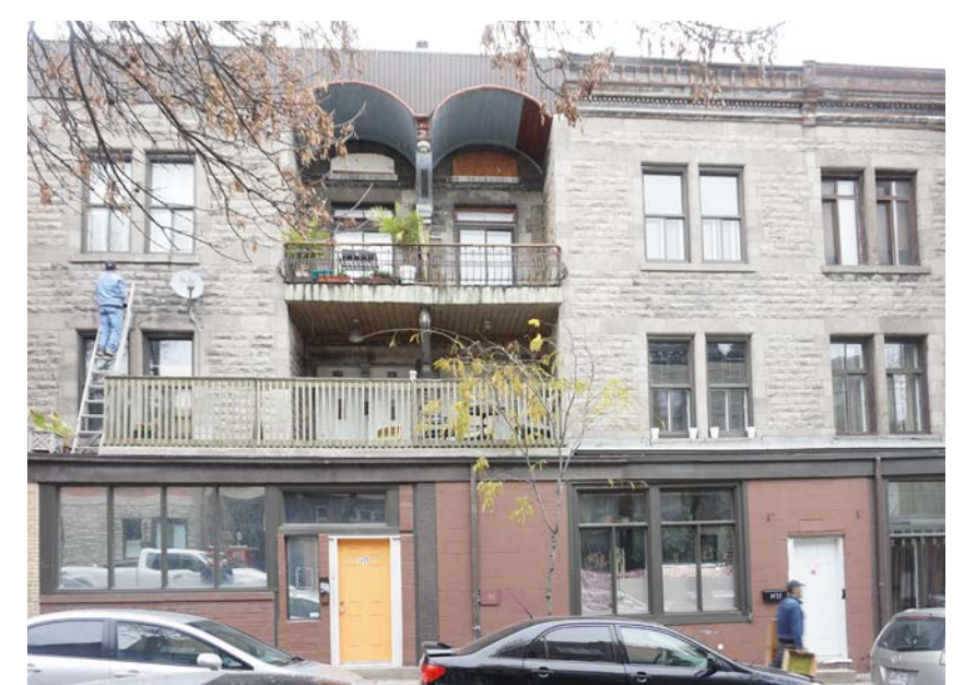
Ce bâtiment de la rue Montcalm a perdu de ses propriétés architecturales d'origine.
