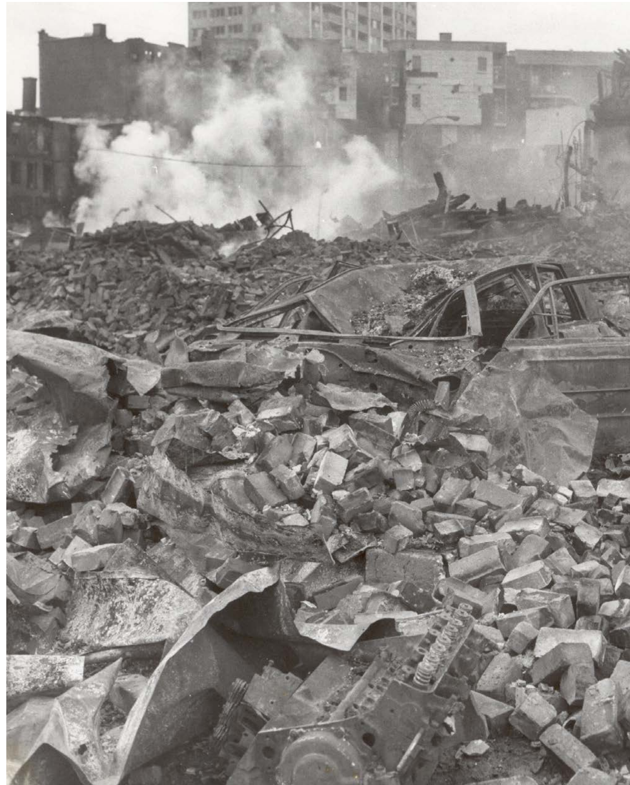
Les incendies du week-end rouge ont détruit plusieurs bâtiments à l'intérieur du quadrilatère formé par les rues Sherbrooke, Wolfe, Plessis et le boulevard de Maisonneuve. 1974. Source : Archives du service des incendies de la Ville de Montréal
