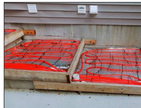
Figure 18 : réseau de tubulure pour trottoir (©CanStockPhoto.com)
