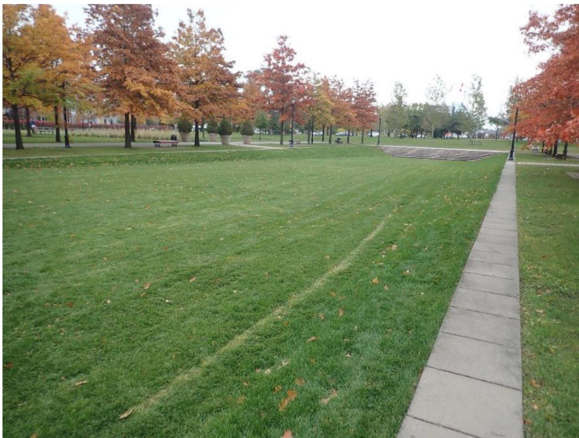
Figure 15. Aménagement gazonné de la partie centrale du parc des Faubourgs créant une pente inverse vers un caniveau.
