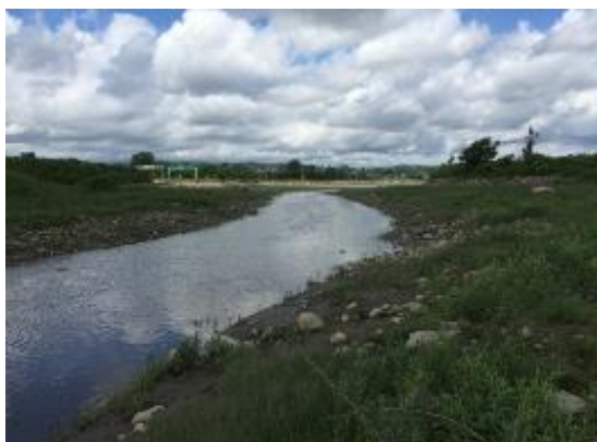
Figure 50. Conduite libérée dans le ruisseau du Moulin (Québec).
