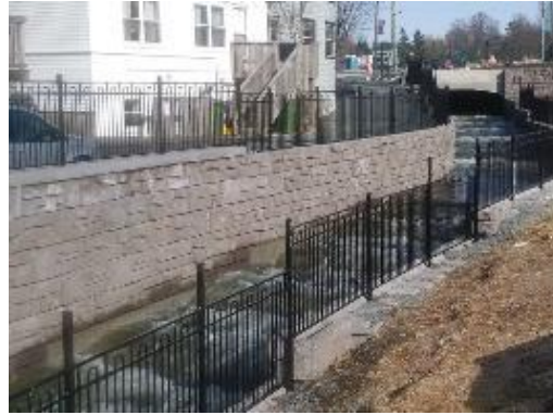
Figure 55. Section de la rivière Saw Mill à New York (États-Unis) avec écoulement par palier.
