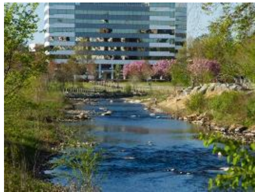
Figure 57. Rivière Mill à Stamford (États-Unis).
