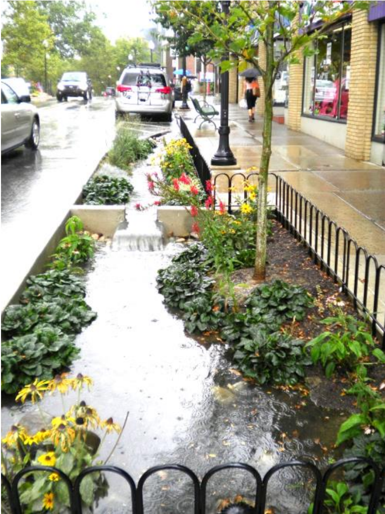
Figure 37. Aire de biorétention lors d'une pluie en bordure de S. Allen Street (Pennsylvanie).
