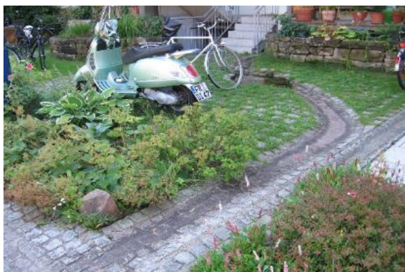
Figure 28. Rigole résidentielle d'eaux pluviales (Fribourg-en-Brisgau).
