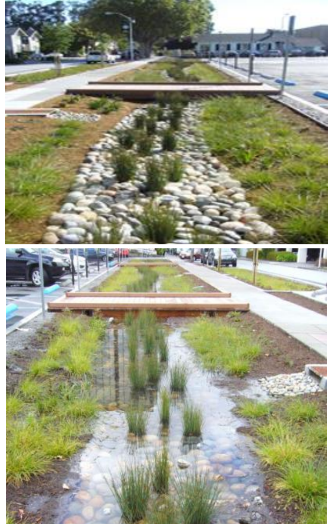
Figure 38. Aire de biorétention avec traverse avant et après une pluie (Burlingame, Californie).
