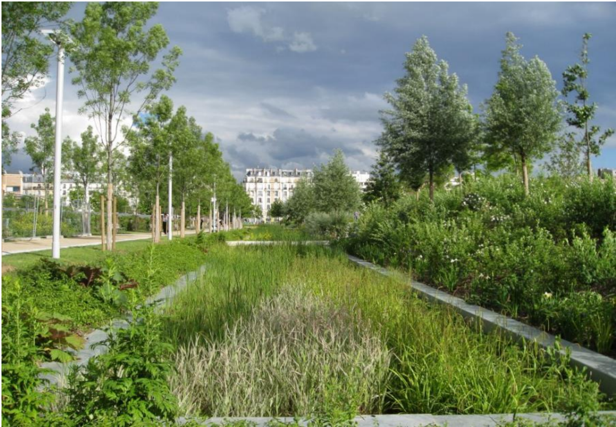
Figure 9. Exemple d'aménagement d'un milieu humide en milieu urbain : Parc Clichy-Batignolles – Martin-Luther-King à Paris.
