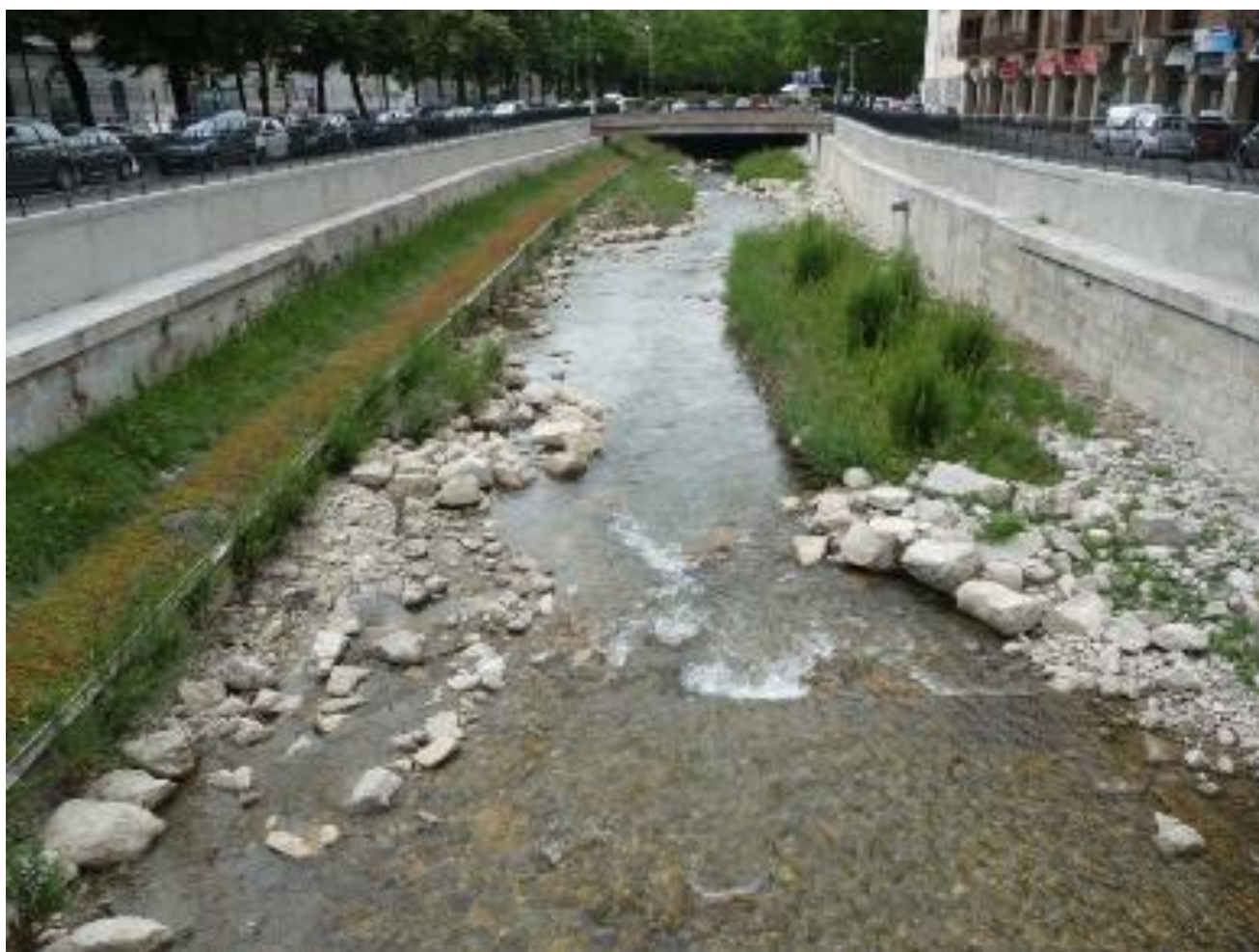
Figure 40. Cours d'eau aménagé entre deux murs de béton.
