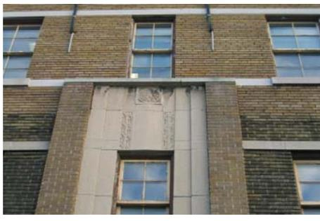
Détails art déco en éléments de béton.
