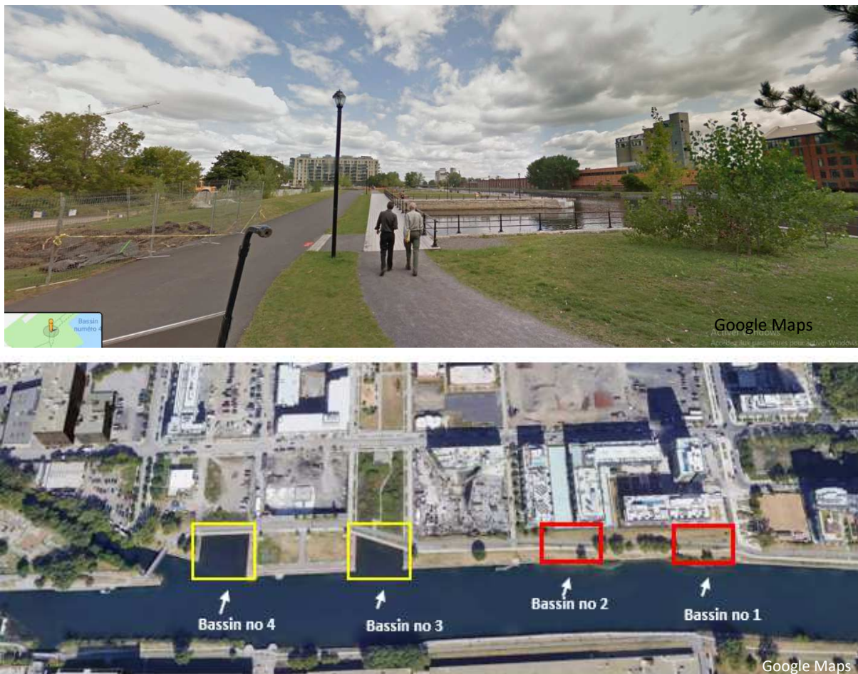
Figure - Réduction de la largeur du parc linéaire aux Bassins du Nouveau Havre
