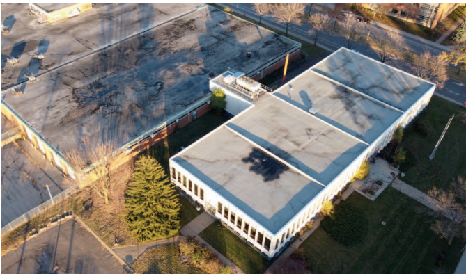
60. Phase laboratoire (9515 St-Hubert) et entrepôt à déconstruire
