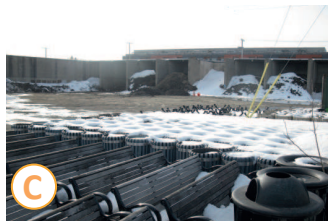
Entreposage de vrac, de mobilier et de matériaux
