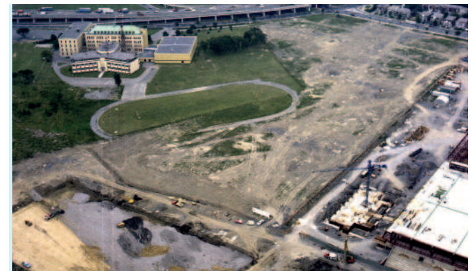
68. Construction du Complexe sportif Claude-Robillard, au nord du Collège André-Grasset, en 1975
