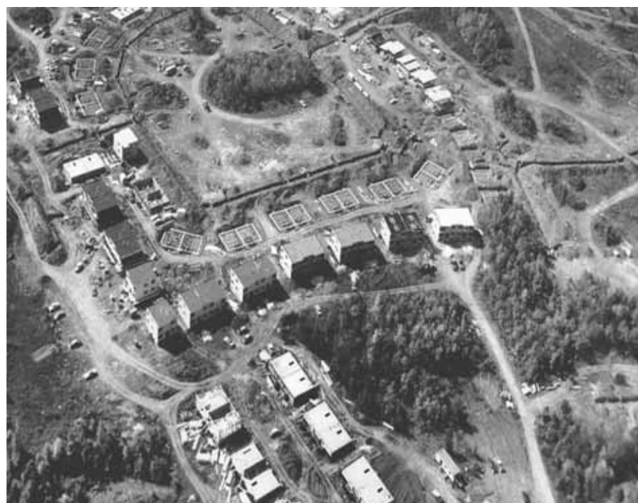
Figure 13: Construction de la première coopérative en 1962. Source: Benoît Brouillette via Flickr.com
