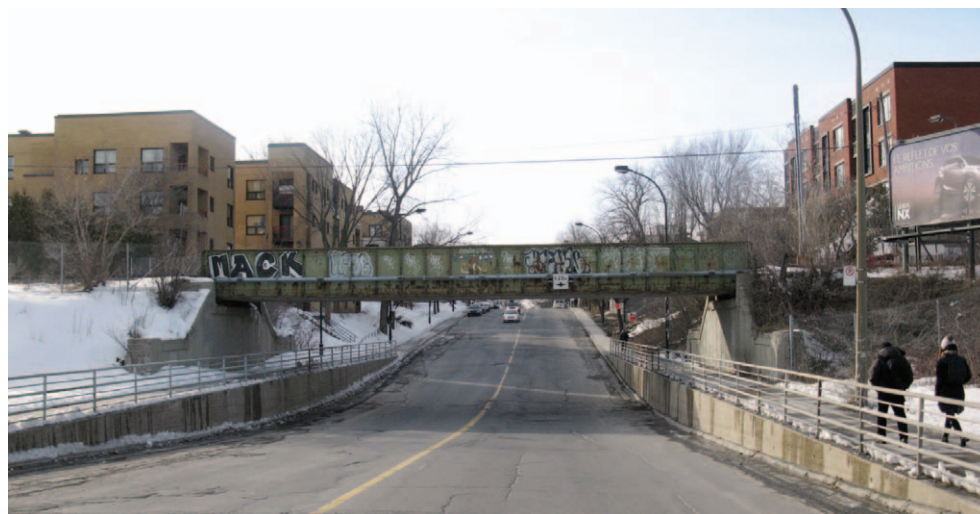
Viaduc rue St-Hubert
