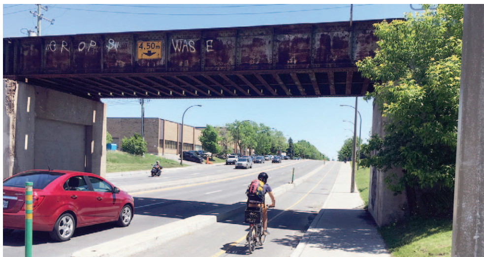
Viaduc avenue Christophe-Colomb
