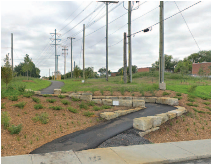
Aménagement sous la ligne à haute tension, rue Saint-Hubert
