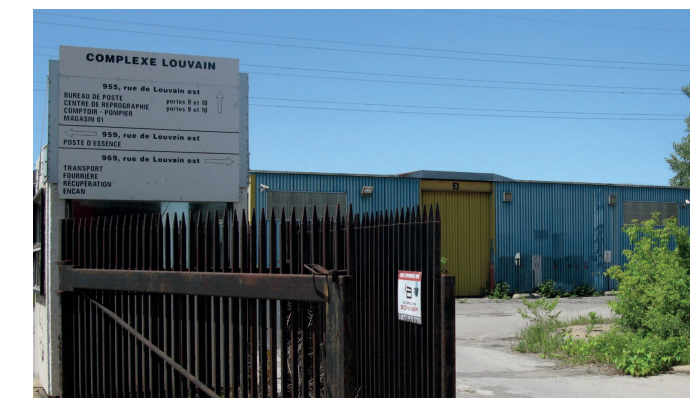
3. Une entrée véhiculaire au site, rue de Louvain Est
