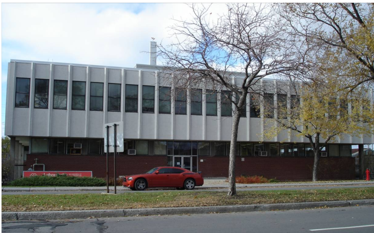
Fig.14 : 999, rue de Louvain Est (Laboratoire Cour De Louvain) (ouvrage 0044)
