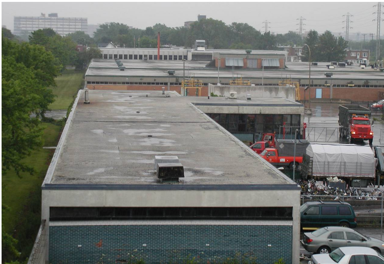
Fig.10 : 969, rue de Louvain Est (Entrepôt Récupération Cour De Louvain) (ouvrage 0056)
