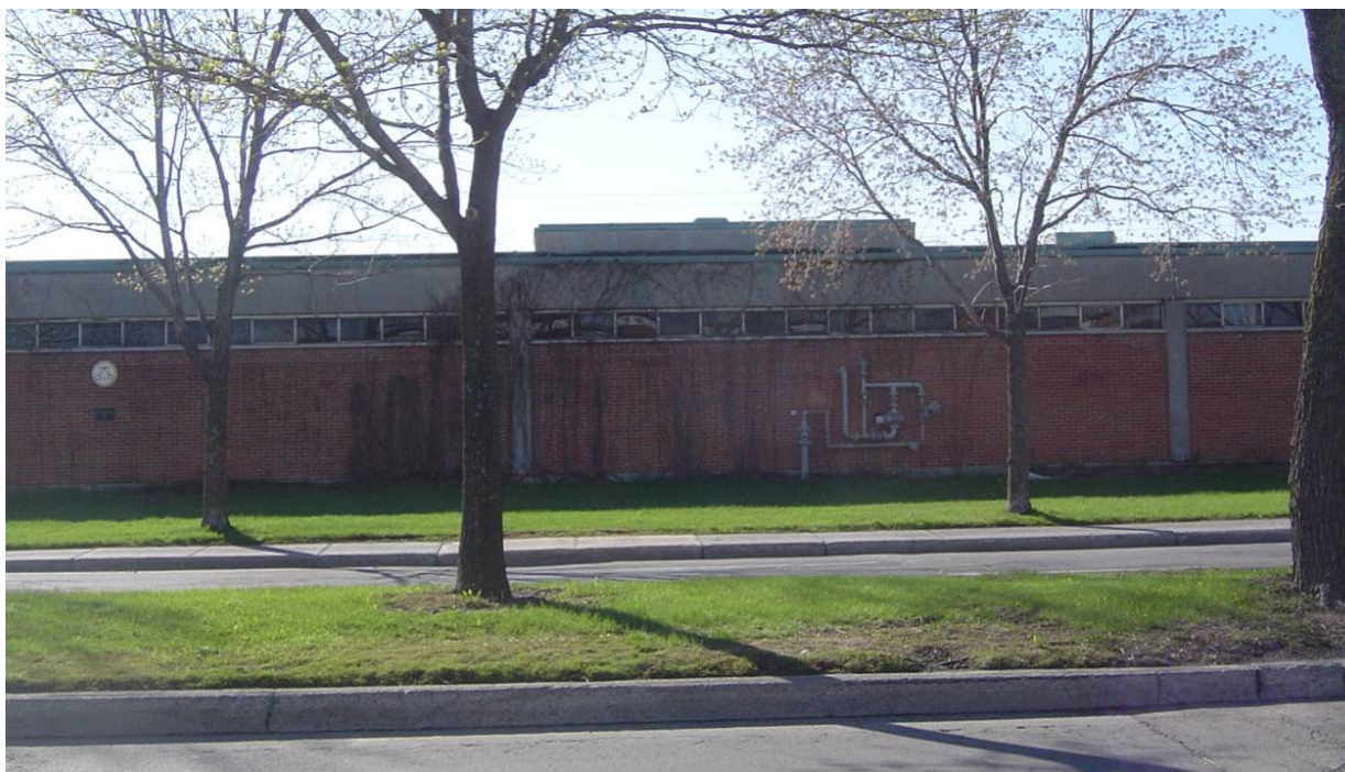
Fig.6 : 955, rue de Louvain Est (Centre de distributions Louvain (Mag.#1)) (ouvrage 0430)
