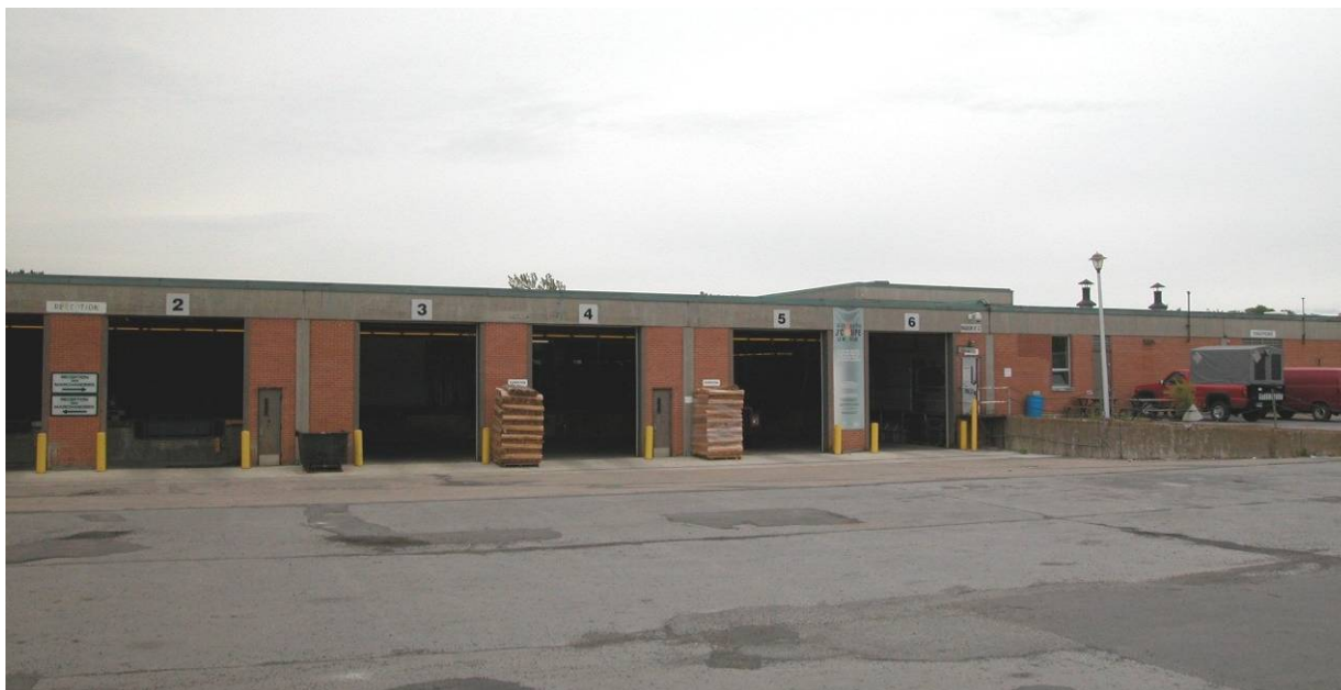
Fig.7 : 955, rue de Louvain Est (Centre de distributions Louvain (Mag.#1)) (ouvrage 0430)
