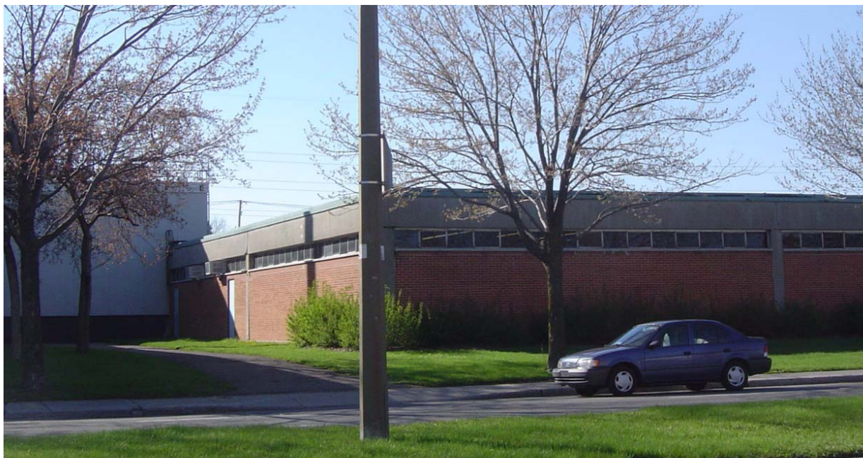
Fig.5 : 955, rue de Louvain Est (Centre de distributions Louvain (Mag.#1)) (ouvrage 0430)
