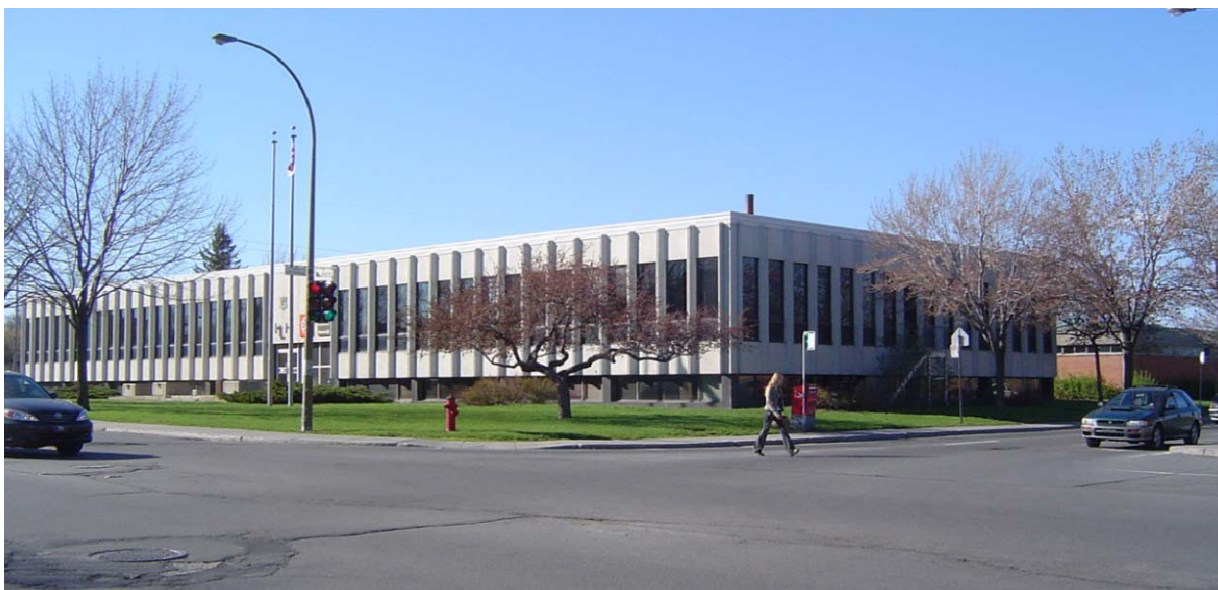
Fig.3 : 9515, rue Saint-Hubert (ouvrage 0478)
