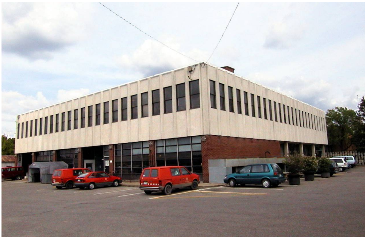
Fig.13 : 999, rue de Louvain Est (Laboratoire Cour De Louvain) (ouvrage 0044)
