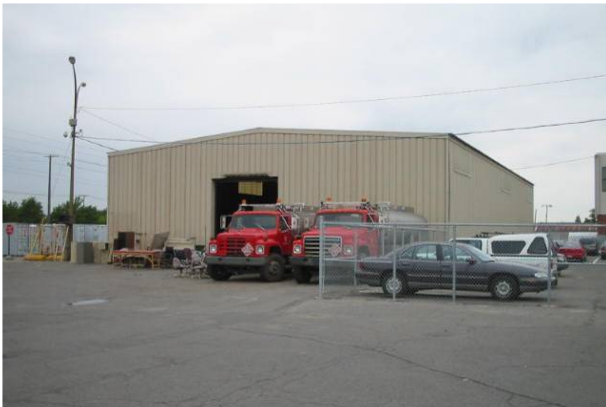
Fig.11 : 969, rue de Louvain Est (Entrepôt Encans Cour De Louvain) (ouvrage 0141)
