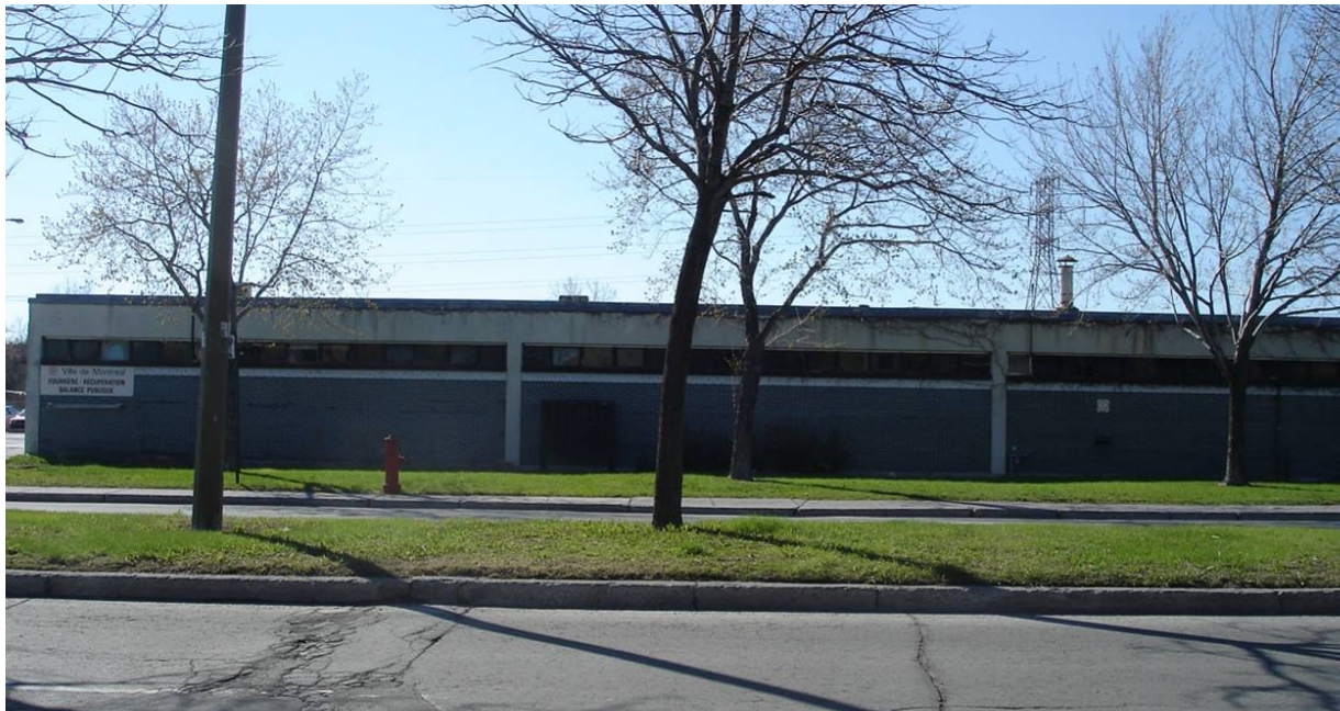
Fig.9 : 969, rue de Louvain Est (Entrepôt Récupération Cour De Louvain) (ouvrage 0056)
