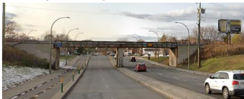
Figure 2-41 : Passage inférieur sur l'avenue Christophe-Colomb
