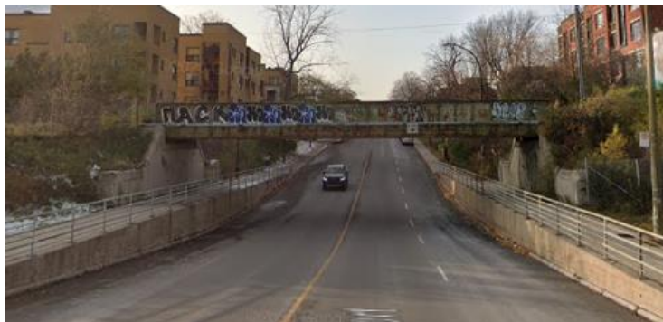
Figure 2-40 : Passage inférieur sur la rue Saint-Hubert
