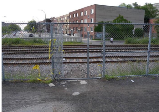
Figure 5-10 : Passage informel d'une voie ferrée à Montréal
