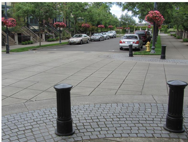
Figure 5-22 : Exemples d'intersections surélevées
