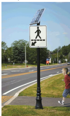
Figure 5-7 : Signalisation lumineuse pour passage piétonnier
