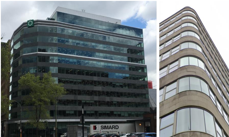
Figure 5: Angles de l'édifice Sommer (à gauche) et de l'édifice du 1255 Phillips Square (à droite).
