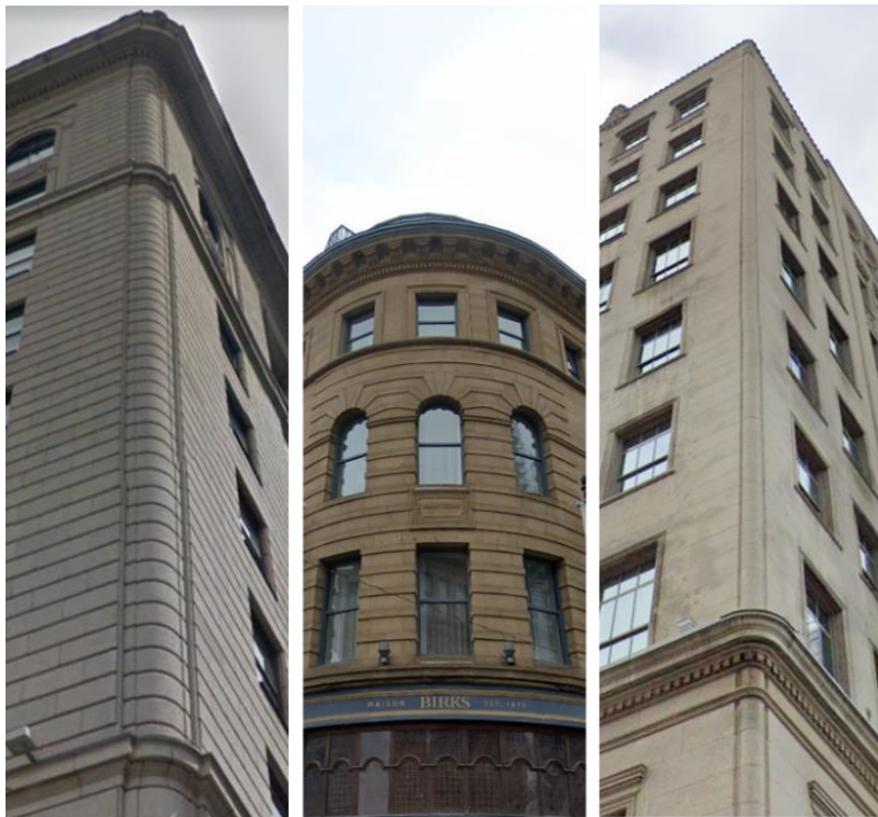
Figure 4: Angles en maçonnerie arrondie du bâtiment de la Canada Ciment Co. (à gauche), de la Maison Birks (au centre) et du Centre Eaton (à droite). © Google Streetview
