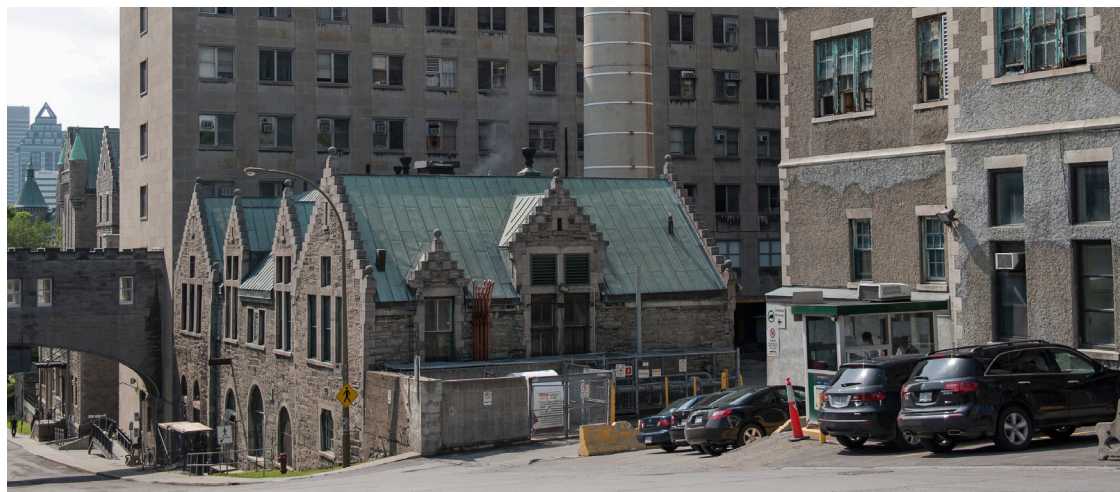
La chaufferie. Photo VM 2013.
