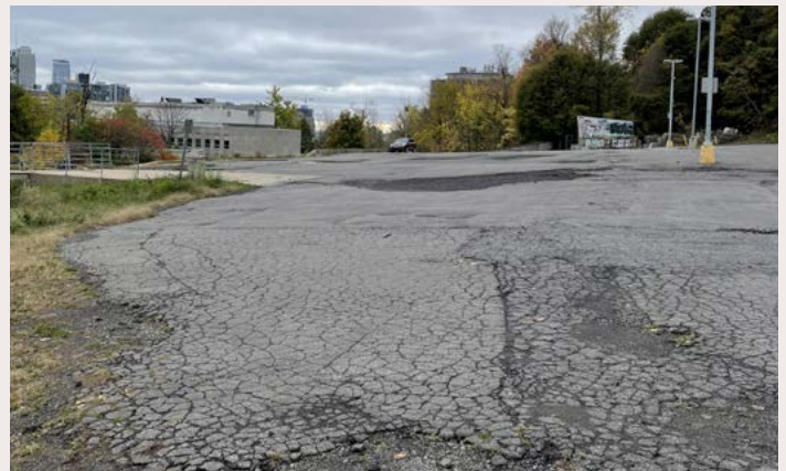
Vue des espaces de stationnement au nord de Ravenscrag laissés à l'abandon ayant le potentiel d'être réaffectés en jardins historiques ou en plaines.
