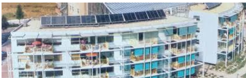
Panneaux solaires en toiture
