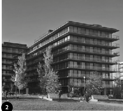
2 RUE DES BASSINS
