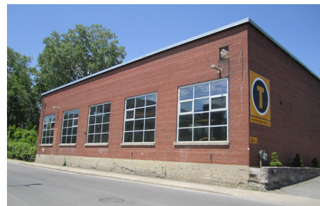
30. Ancienne chaufferie Montreal Dry Dock, rue Oak
