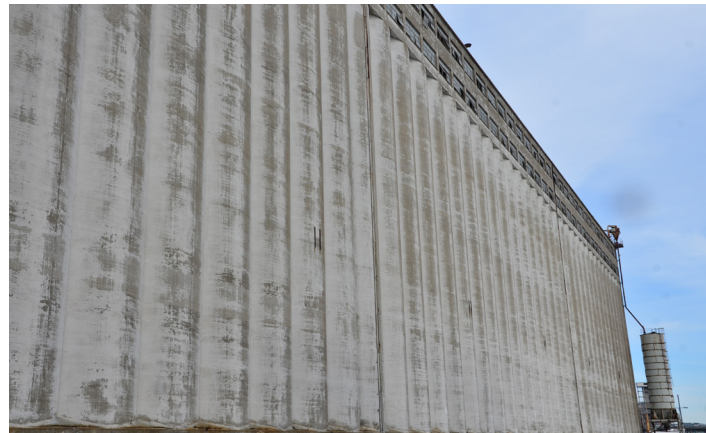
95. Silos en béton de l'élevateur B-1
