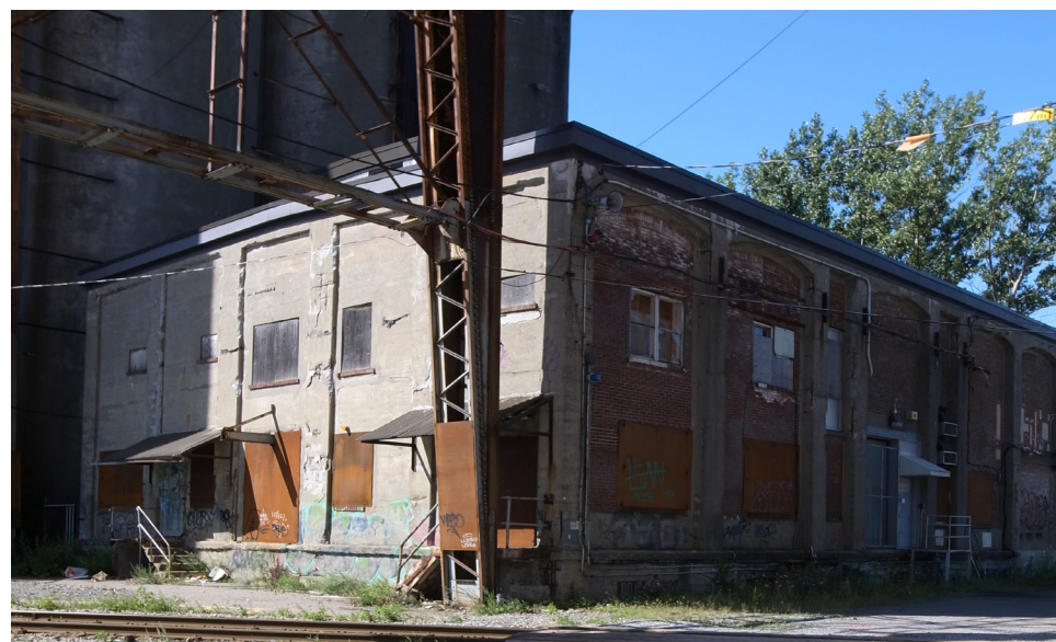
81. Sous-station électrique adjacente à l'annexe
