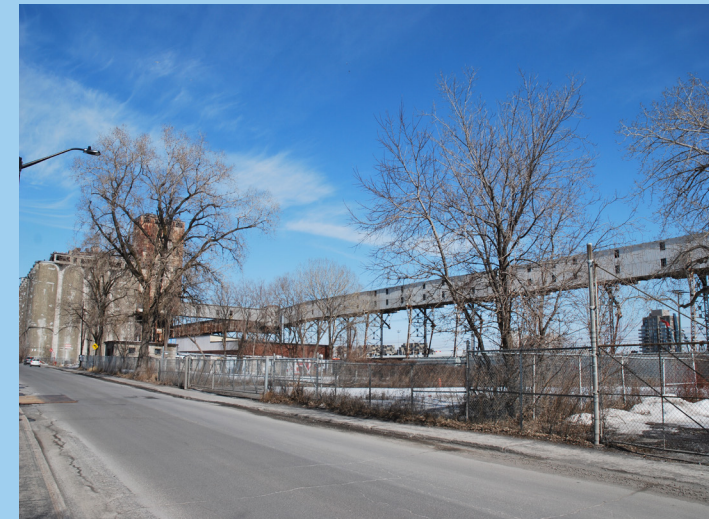
72. Ouverture visuelle sur les convoyeurs et les activités portuaires à partir de la rue Mill
