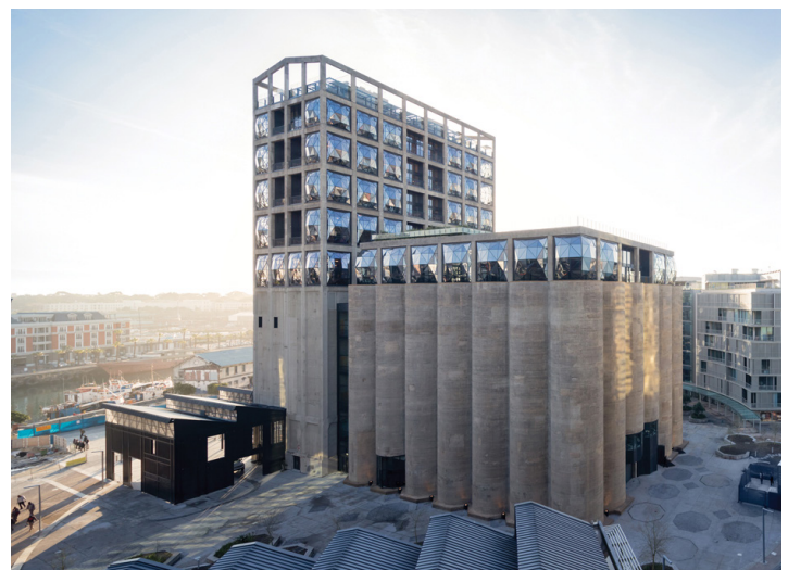
62. Exemple de réhabilitation d’anciens silos en musée, Zeitz Museum of Contemporary Art Africa, Cape Town, Afrique du Sud
