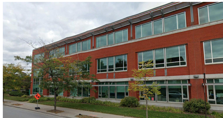
18. Exemple de front bâti continu et verti sur la rue Bridge
