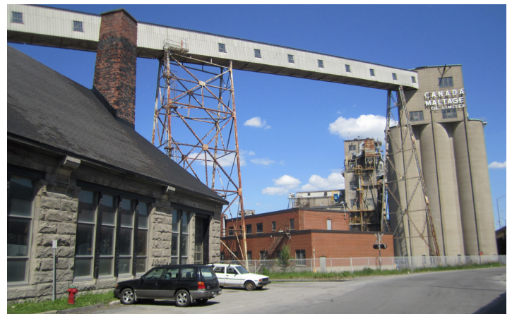
49. Silos de Canada Maltage et les convoyeurs aériens, rue Riverside
