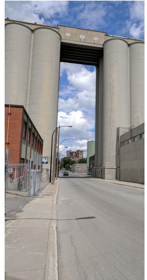
61. Robustesse et grandeur des bâtiments existants, rue Mill
