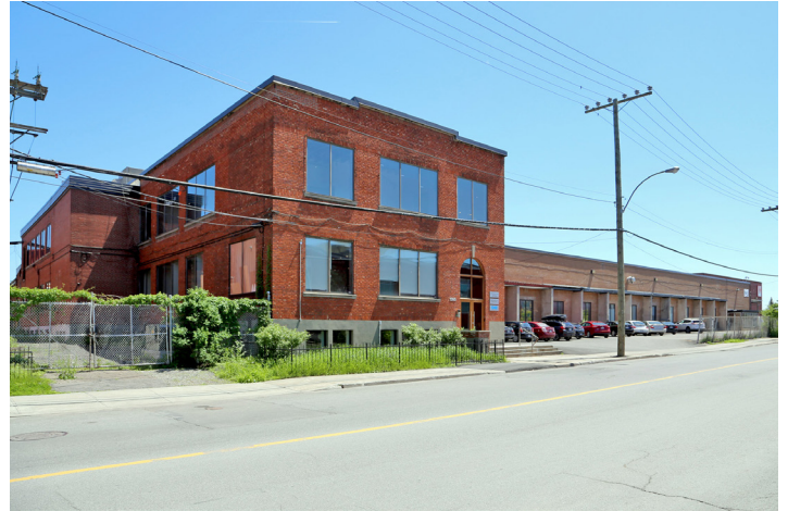
35. Bâtiment de Canada Packers, rue Mill
