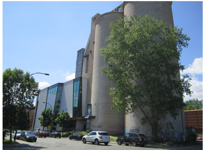
3. Transformation de silos en centre d'escalade, rue Saint-Patrick
