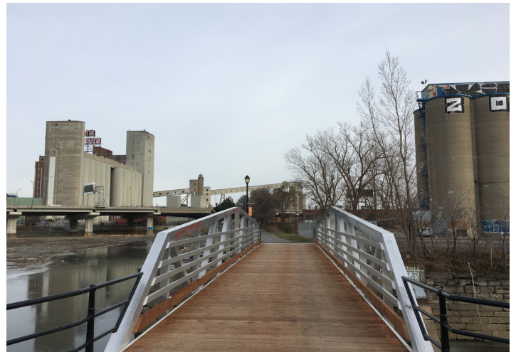
29. Vue sur les silos d'ADM et de P&H Milling depuis la passerelle Wellington de Parcs Canada
