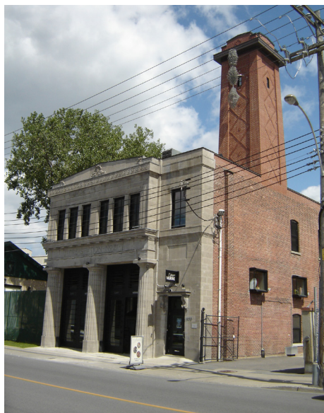
33. Ancienne caserne de pompier, rue Mill
