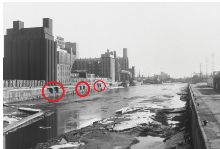
93. Pertuis (prises d'eau) visibles le long du bassin n° 2 du canal de Lachine, 1951
