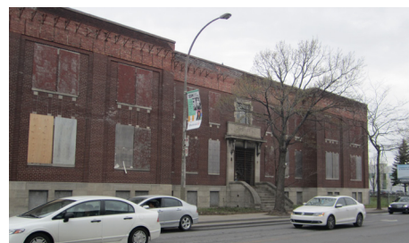
31. Ancien immeuble administratif du CN, rue Bridge
