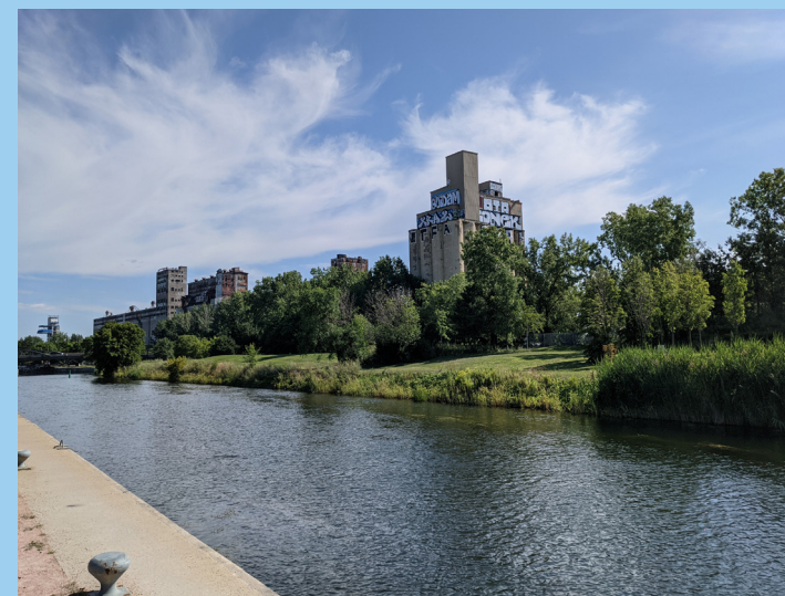
68. Vue sur les silos Rozon et le silo n° 5 depuis la rive nord du canal de Lachine
