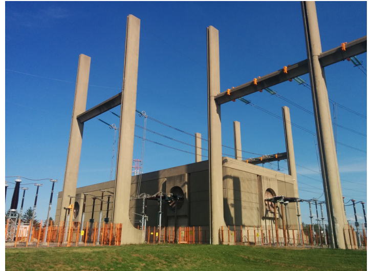
48. Poste Viger, chemin des Moulins
