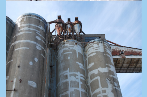
88. Exemples de composantes de l'élevateur B-1 et de l'annexe à préserver
