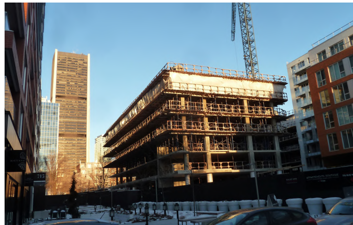
Construction du projet 21 e arrondissement, près de Bonaventure
