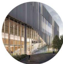
École secondaire LaSalle - en construction (Lemay / Vincent Leclerc / Leclerc architects)
