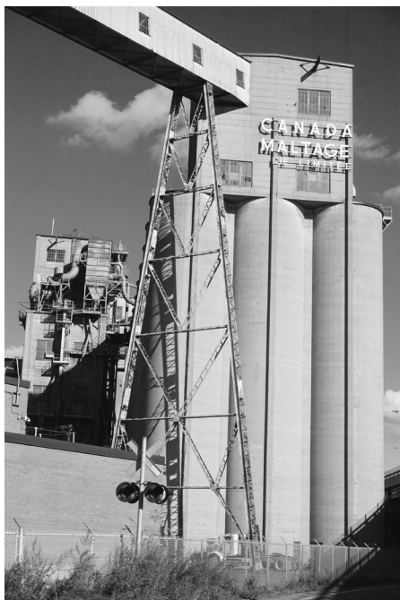
Vue sur les silos de Canada Maltage
