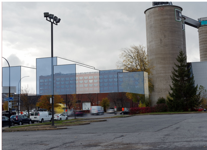
Figure 4 : Vue vers le sud-ouest à partir du stationnement situé au coin nord-est des rues Saint-Patrick et de Condé. Le Nordelec disparaît complètement.
