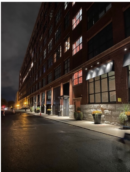
Figure 6 : Éclairage des entrées 1730 et 1740 Saint-Patrick dans l'axe « de la Sucrierie » suite aux corrections récentes apportées par le Groupe Allied (10 octobre 2023).
