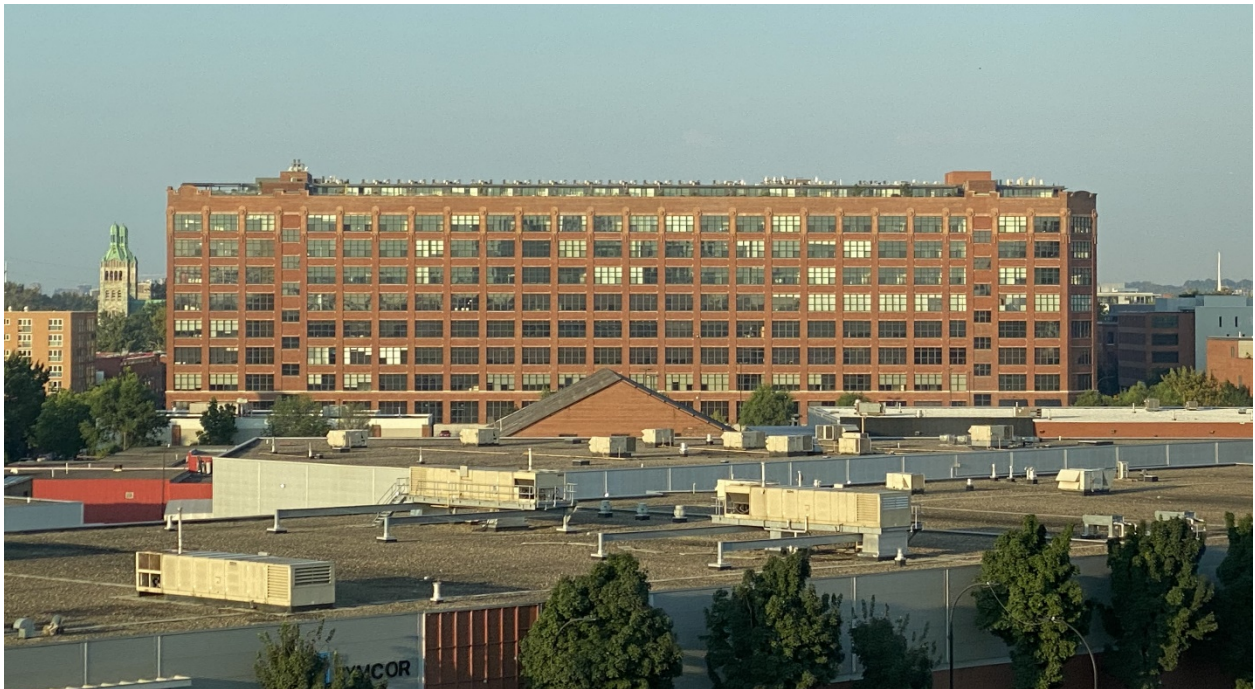
Figure 1 : Vue du Nordelec vers l'ouest à partir du REM
