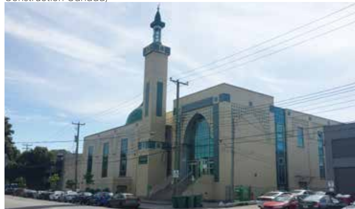
Fig. 222. Centre islamique du Québec (ICQ) implanté sur le chemin Laval à proximité de la rue Grenet (Source: Provencher Roy)
