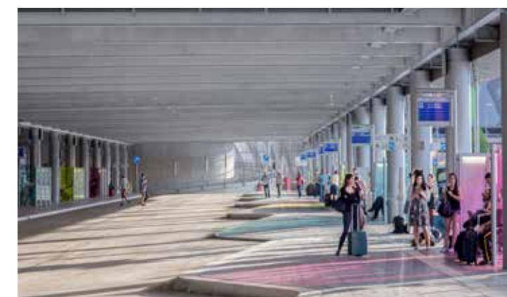
Fig. 290. Aménagements intérieurs conviviaux et sécuritaires du terminus d'autobus, Aéroport de Stuttgart, Allemagne (Source: Wulf Architekten)
