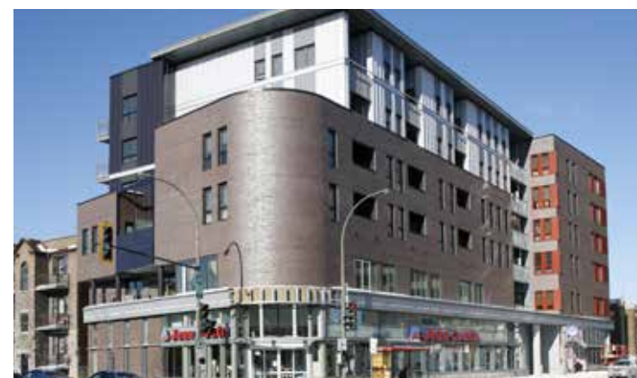
Fig. 293. Terminus intégré à un projet mixte (résidence pour personnes âgées/ bureau), Station de métro Jean-Talou, Montréal (Source: Résidence en harmonie)
