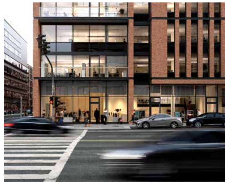
Fig. 266. Façade transparente en relation avec le domaine public, Hambourg, Allemagne (Source: GMP Architekten)
