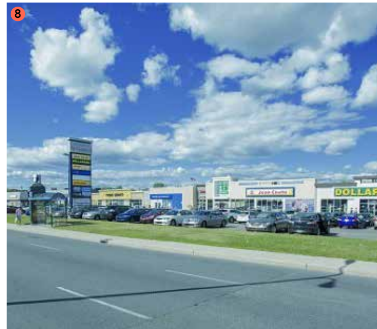
Fig. 11. Galerie Saint-Laurent, boulevard Marcel-Laurin (Source : Groupe Shapiro)
