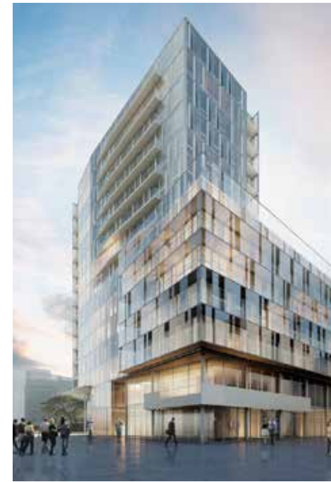
Fig. 263. Modulation volumétrique et gradation des hauteurs, Hambourg, Allemagne (Source: Richard Meier & Partners)
