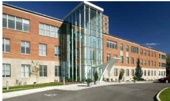
Fig. 221. Carrefour Providence implanté sur la propriété des Soeurs de la Providence aux abords de la rue Grenet (Source: ICB Construction Canada)
