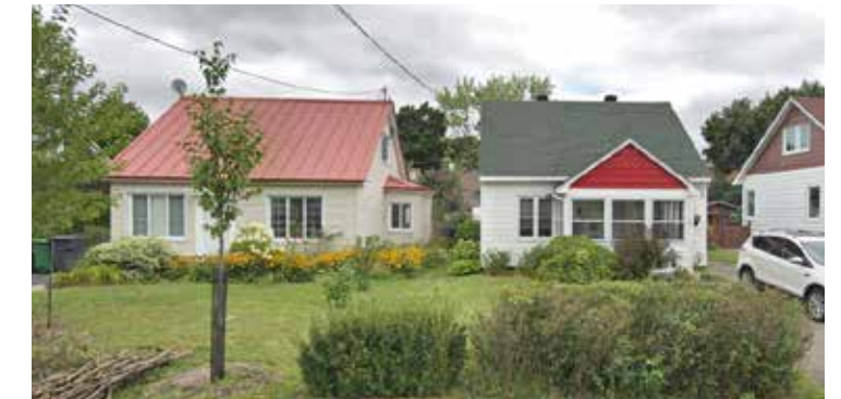
Fig. 111. Rue Stanislas, Quartier Norvick (Source: Google Maps)
