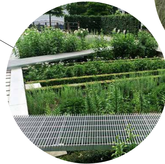
PASSERELLES MÉTALLIQUES TRAVERSANT LES NOUES
