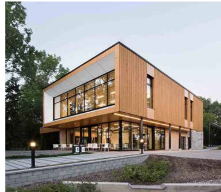
Fig. 270. Premier bâtiment net zéro à Montréal, Ahuntsic-Cartierville (Source: Stantec)
