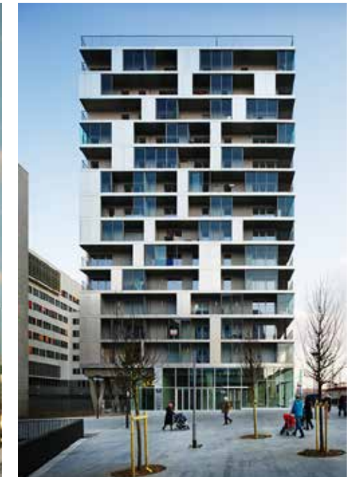
Fig. 265. Bâtiment phare, Paris, France (Source: Amonic Masson, Compte et Wollemweider)
