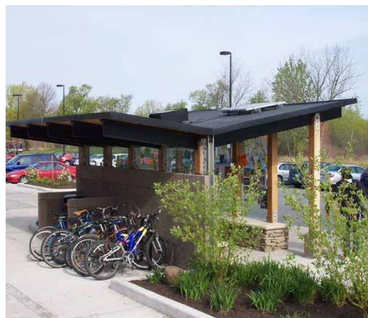
Fig. 300. Stationnement pour vélo abrité (Source: GFLRPC)
