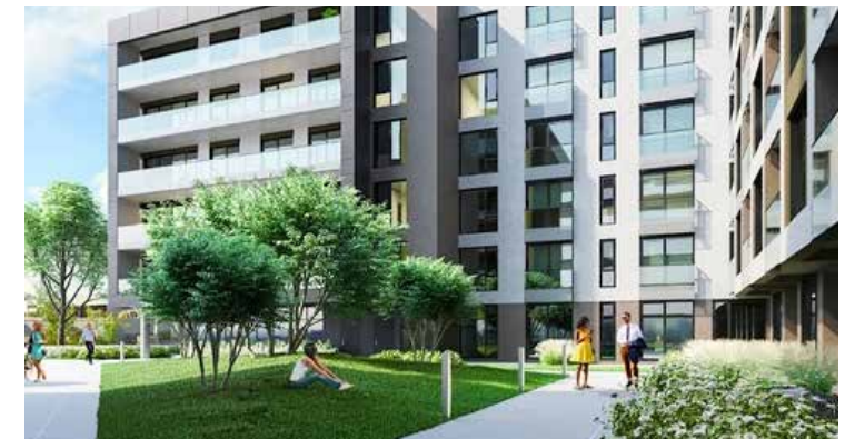
Fig. 124. Immeuble à logements multiples, Ateliers Castelnau, Montréal (Source : Guide habitation)
