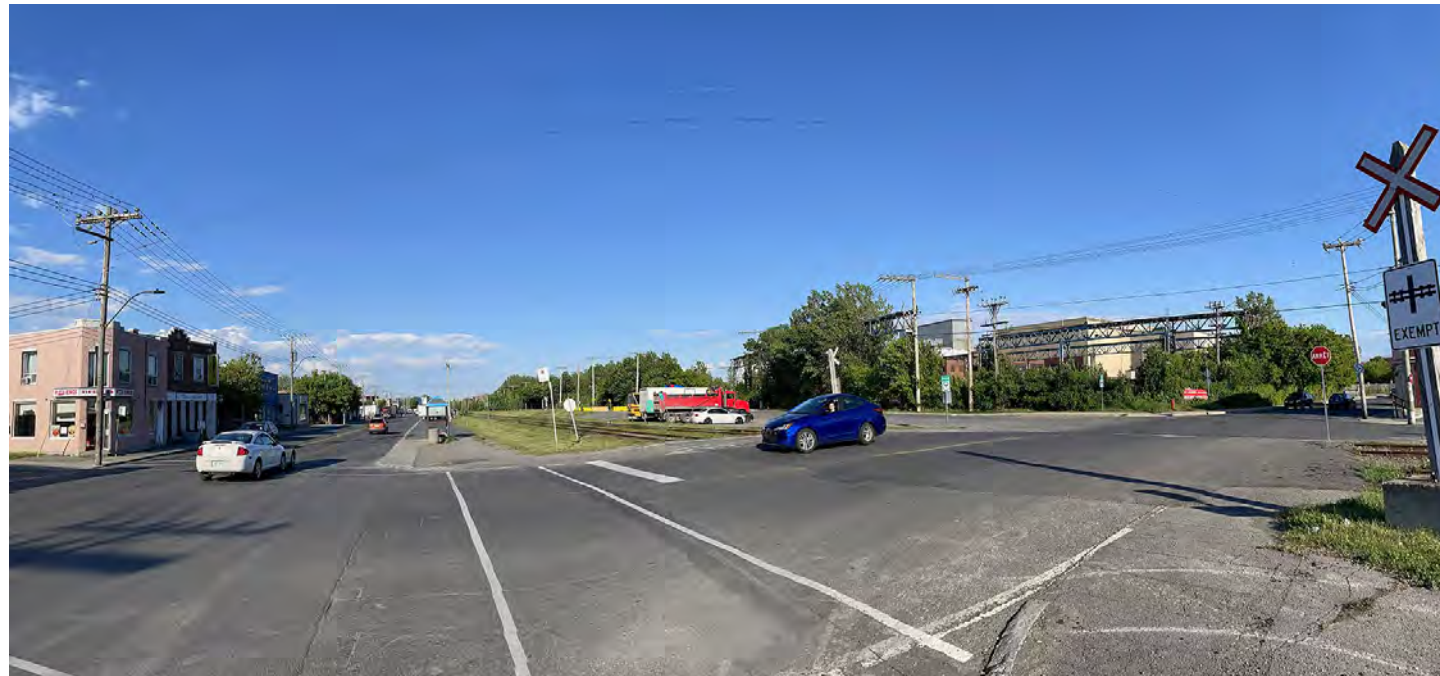
Rue Victoria existante, à l'intersection avec la 6 e Avenue
