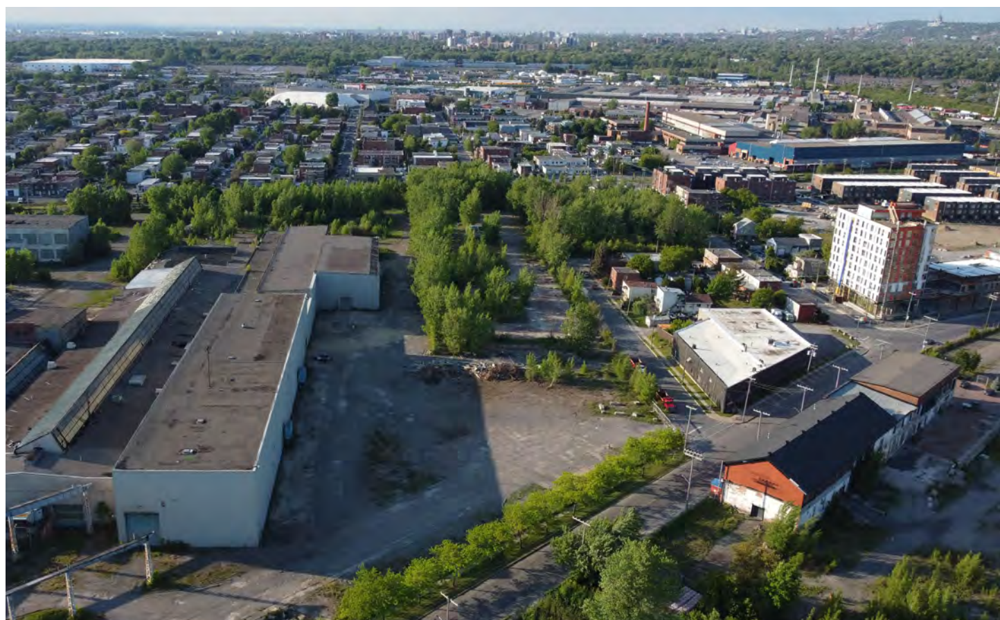
Vue aérienne du secteur en friche de la Dominion Bridge Est (juin 2021)
