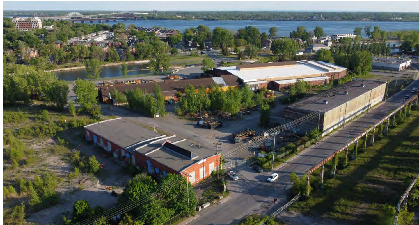
Vue aérienne du complexe de la Cintube, avec, en avant-plan, la partie ouest de l'ancien complexe de la Dominion Wire (Stelfil) (juin 2021)
