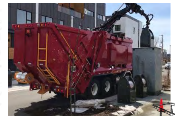
Ramassage par grue de bacs enfouis (source : Durabac)
