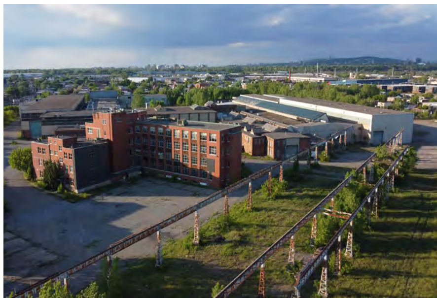
Vue aérienne des ponts roulants et des bâtiments administratifs de la Dominion Bridge Ouest (juin 2021)
