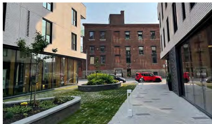
Exemple d'espace perméable verti (Griffintown, Montréal)
