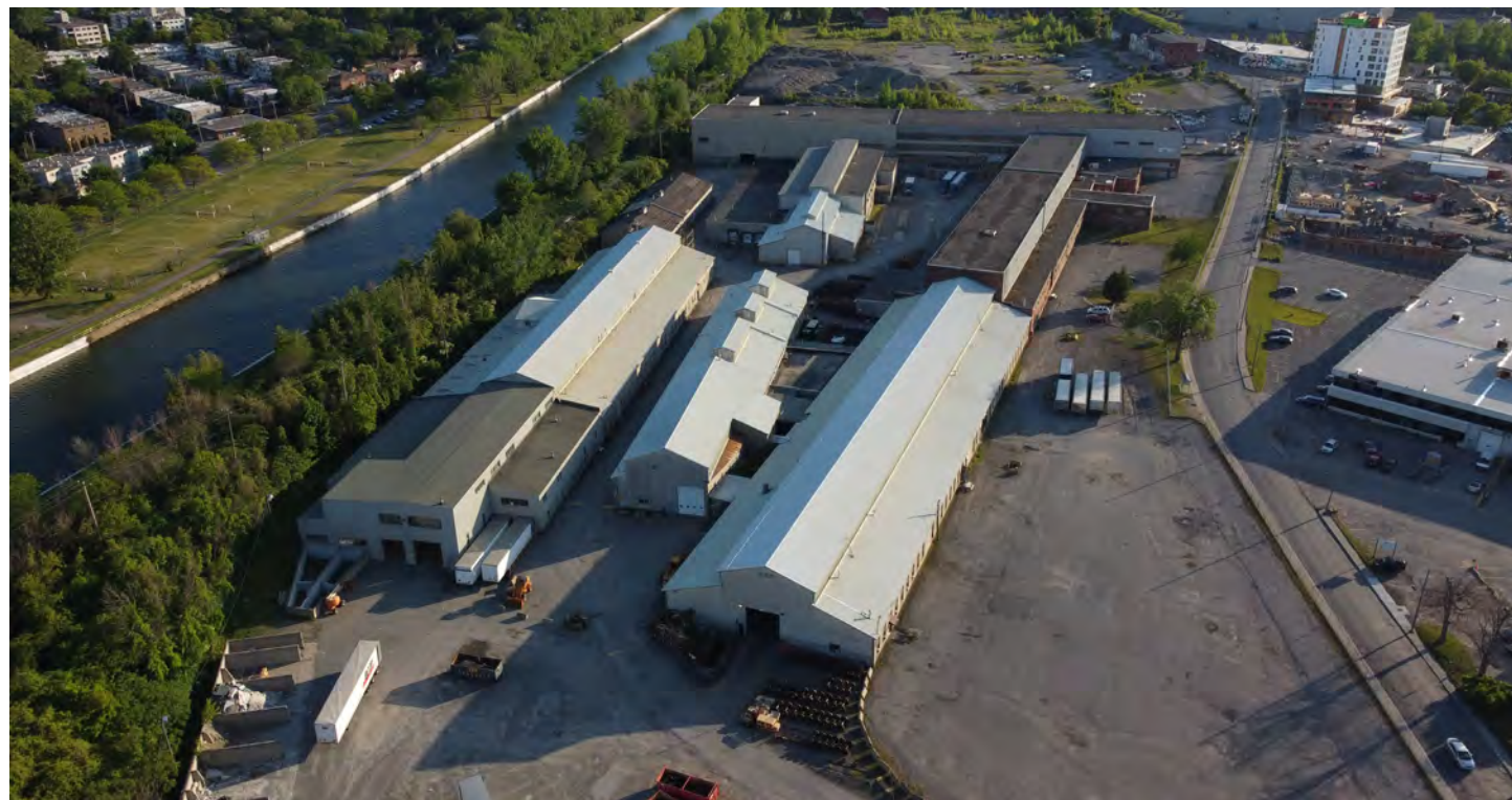
Vue aérienne du complexe Allis-Chalmers (juin 2021)
