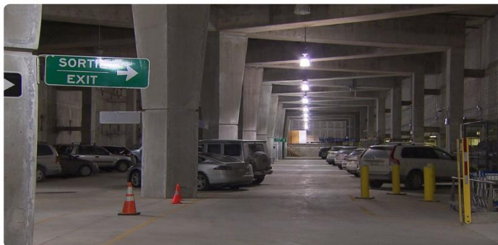
L'espace qui devait abriter la nouvelle gare, situé sous l'actuel hôtel Marriott dans la nouvelle partie de l'aéroport Montréal-Trudeau.
