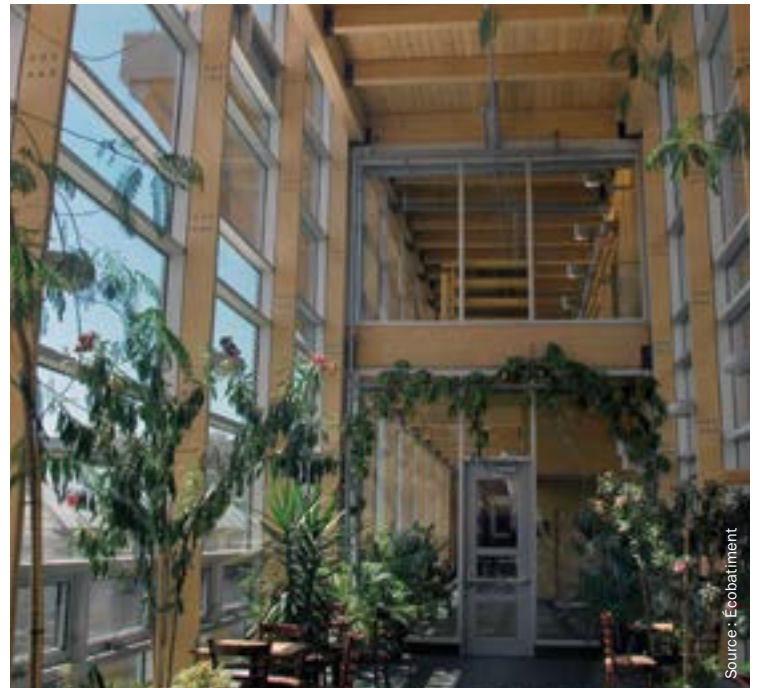
Pavillon Kruger (Québec), structure en bois et éclairage naturel
