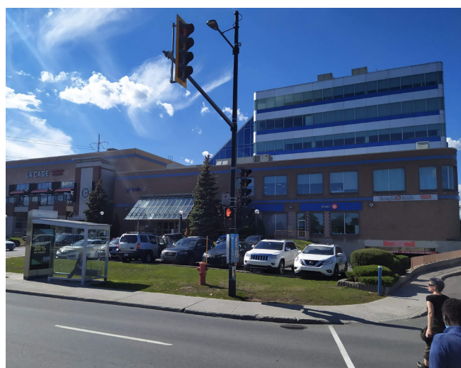
La façade principale de la Place Versailles avec sa tour de bureaux.
