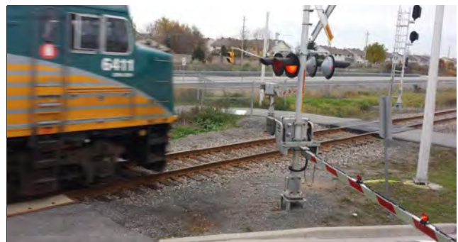
Figure 1.8 – Passage à niveau traversant une piste cyclable.
