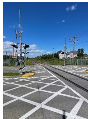
Vue vers l'est du passage à niveau du boulevard Le Bourg Neuf.
