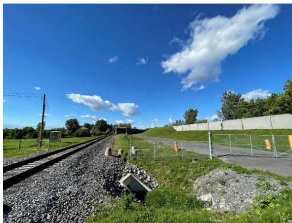
Figure 16 : Fin du chemin de fer couvert et écran antibruit entre Le Gardeur et Charlemagne.
