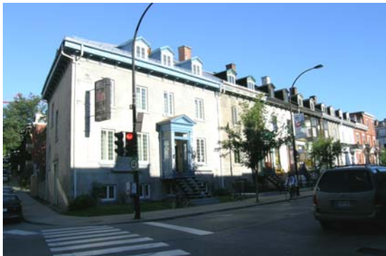
Terrace Emma , rue Ontario (2004).
