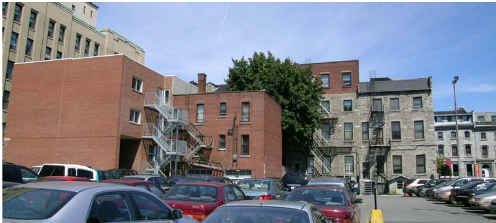
Photo de l'arrière des cinq édifices (2004).
