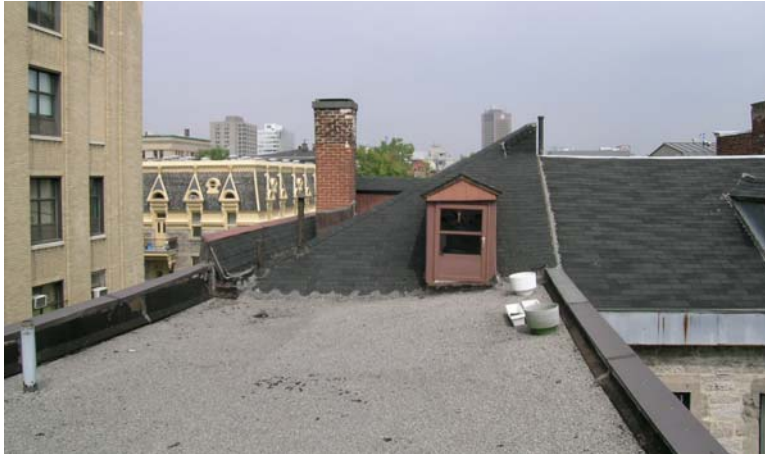
Le toit à trois versants du 1048 Saint-Denis (2004).
