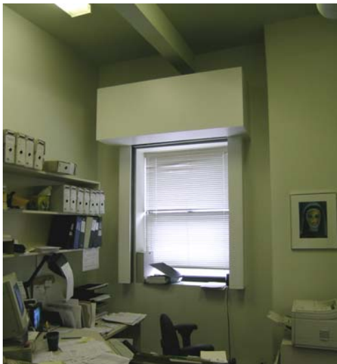
Rideau coupe-feu installé suite au percement du mur mitoyen (2004).
