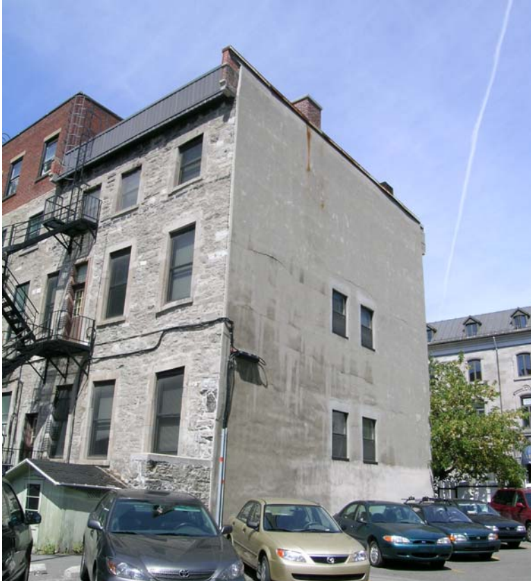
Façade arrière du 1032-1034, rue Saint-Denis (2004).
