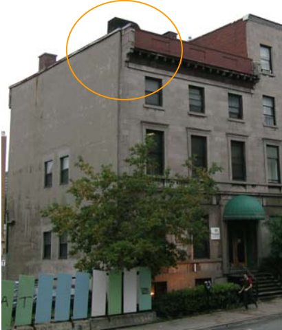
Corbeaux de l'ancien profil des murs coupe-feu (2004).
