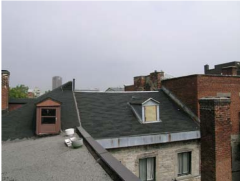
Le toit à trois versants du 1048, rue Saint-Denis (2004).
