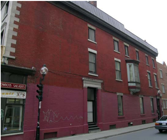
La façade nord du 1048, rue Saint-Denis / 364 - 372 de la Gauchetière (2004).
