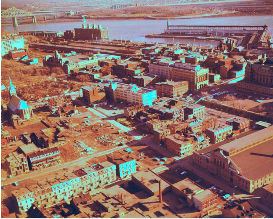
Photographie de 1965 illustrant le début des démolitions liées à la construction du métro. Fonds Armour Landry, ANQ.
