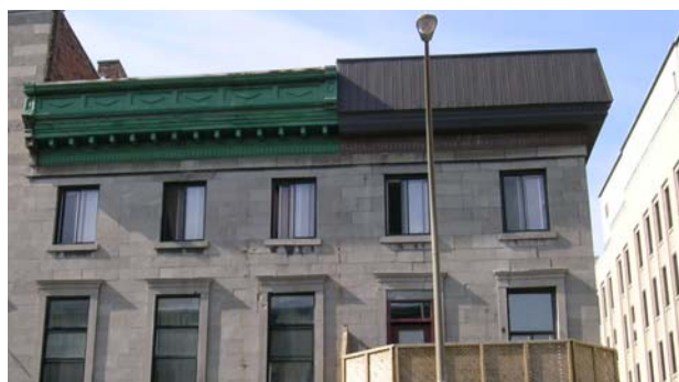
Corniches des 1044 et 1048, rue Saint-Denis (2004).
