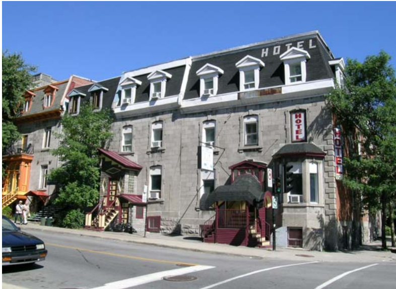
Exemple d'ensemble de maisons en terrasse, rue Saint-Hubert, au nord de l'avenue Viger (2004).
