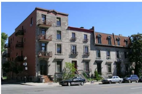
Rue Berri. Interventions disparates sur un ensemble de quatre unités, à l'origine similaires (2004).
