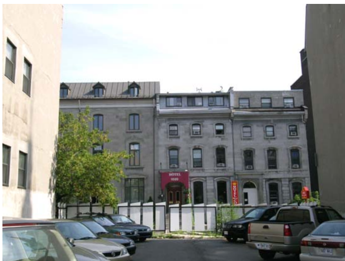
Photo des immeubles du versant Est de la rue Saint-Denis à partir des lots laissés vacants par la démolition du 1026 et 1030. (2004).
