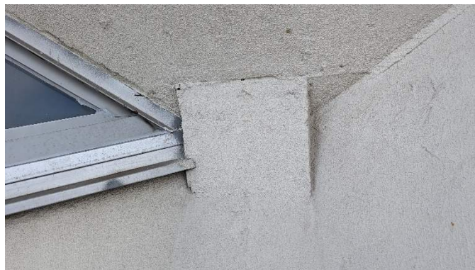
Photo 11: Console d'assise typique des panneaux structuraux de la toiture
