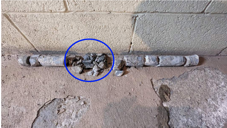
Photo 2 : Carotte intérieure au sous-sol
