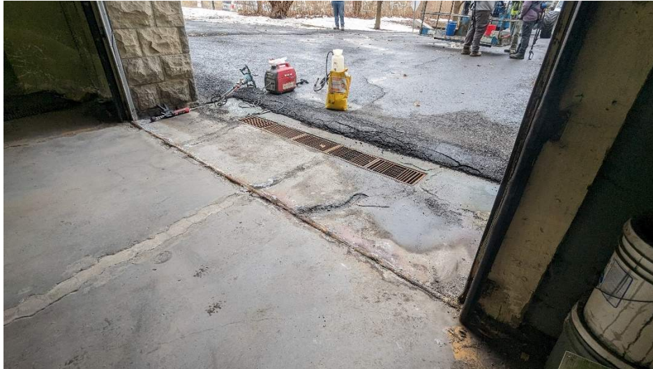
Photo 19 : Caniveau et dalle de transition
