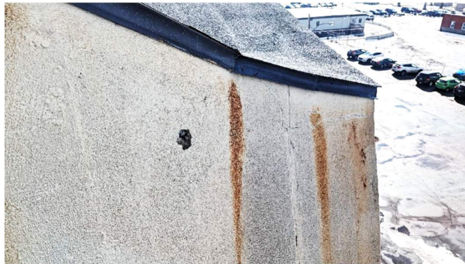
Photo 10: Fissuration et éclat à la tête du premier panneau nord-ouest à la jonction avec le cadre de béton coulé en place
