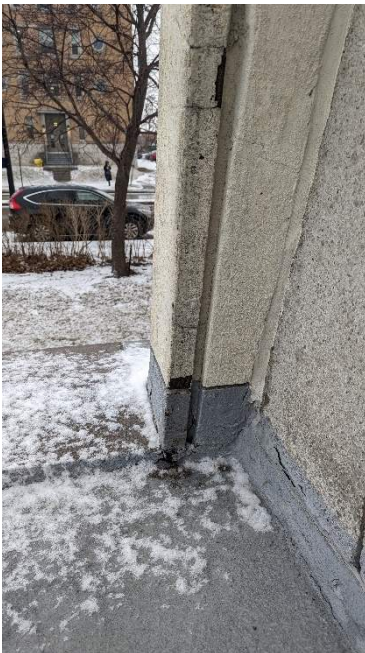
Photo 15: Base des arches
