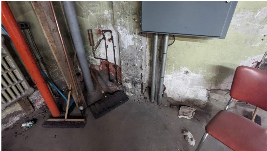
Photo 18 : Délamination à la base des colonnes
