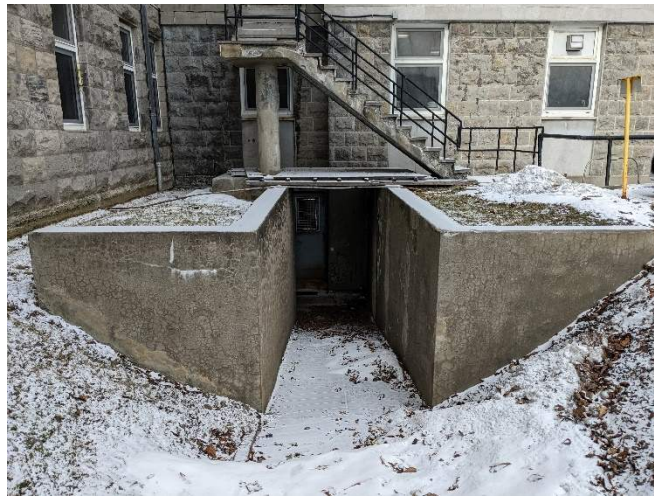
Photo 6 : Vue d'ensemble de l'accès au sous-sol (côté sud)
