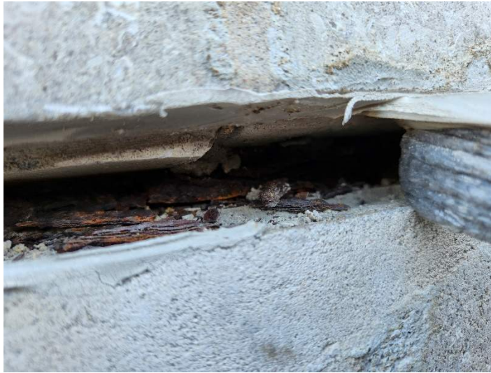
Photo 13 : Lamellage des linteaux (source DMA)
