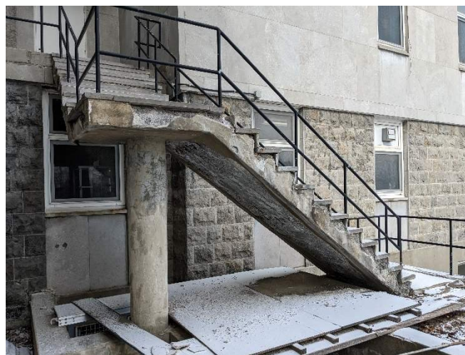
Photo 7 : Vue d'ensemble de l'escalier extérieur (côté sud)
