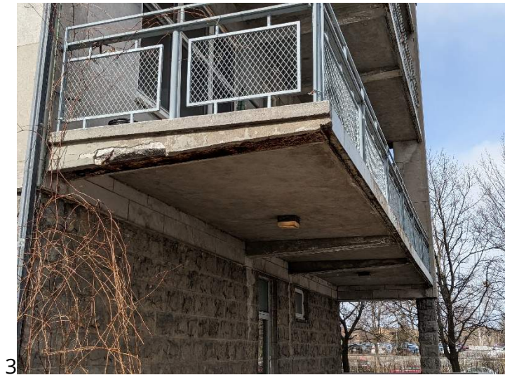
Photo 12 : Balcons – côté est
