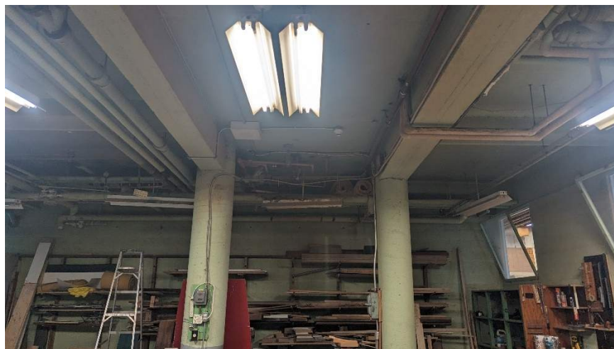
Photo 2 : Structure dalle sur poutre à l'intrados du sous-sol
