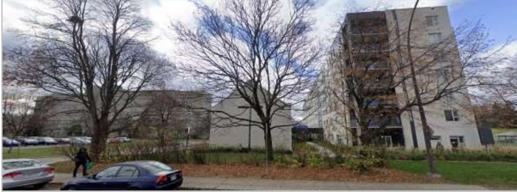
2022, vue du côté est (rue Esther-Blondin) avec la nouvelle résidence et chapelle des sœurs détachée du couvent, dont l'aile de 1967 est visible à gauche
