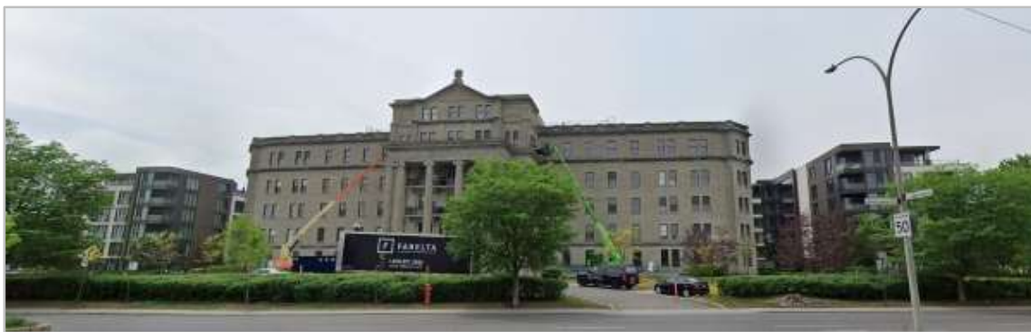
2022 : vue de l'ensemble sur le boulevard Saint-Laurent (Google Maps)
