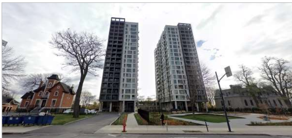
Le site redéveloppé, dont les bâtiments reprennent l'implantation en U du couvent, avec les maisons Judah et Masson conservées, en 2022 (Google Maps)
