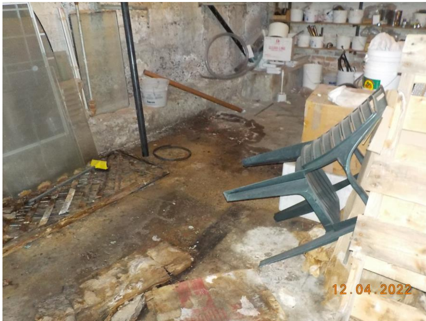
Photo 7 Vue de la dalle de béton de l'ancienne salle d'entreposage de charbon
