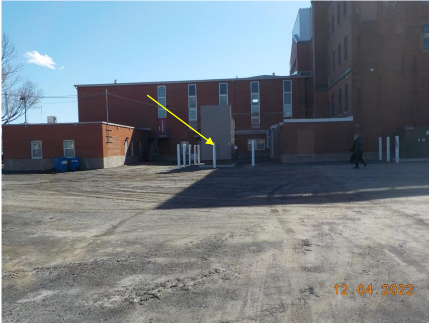
Photo 7 Vue de l'unité de génératrice (ainsi que l'emplacement d'anciens réservoirs souterrains associés aux fournaies du bâtiment) sur la propriété voisine au sud du Site
