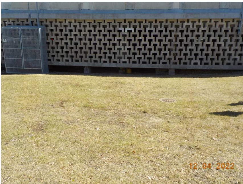
Photo 4 Emplacement des réservoirs souterrains abandonnés
