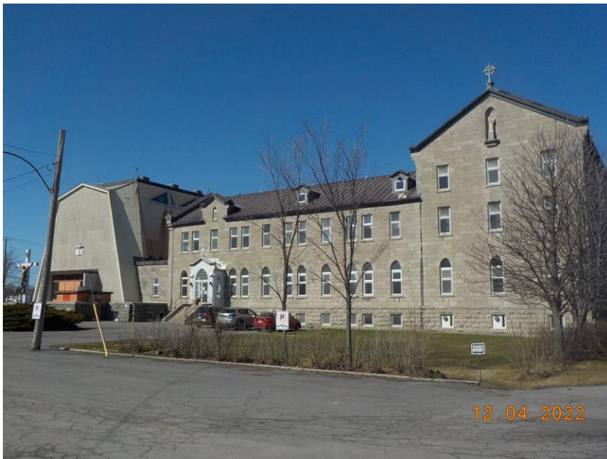
Photo 1 Vue générale de la façade sud du bâtiment
