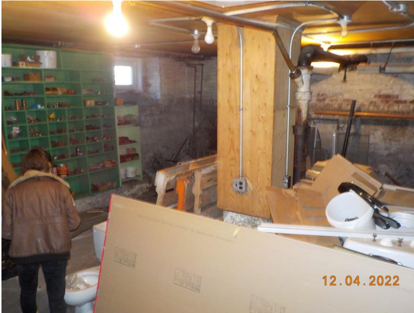
Photo 9 Vue générale de l'ancienne salle d'entreposage du charbon
