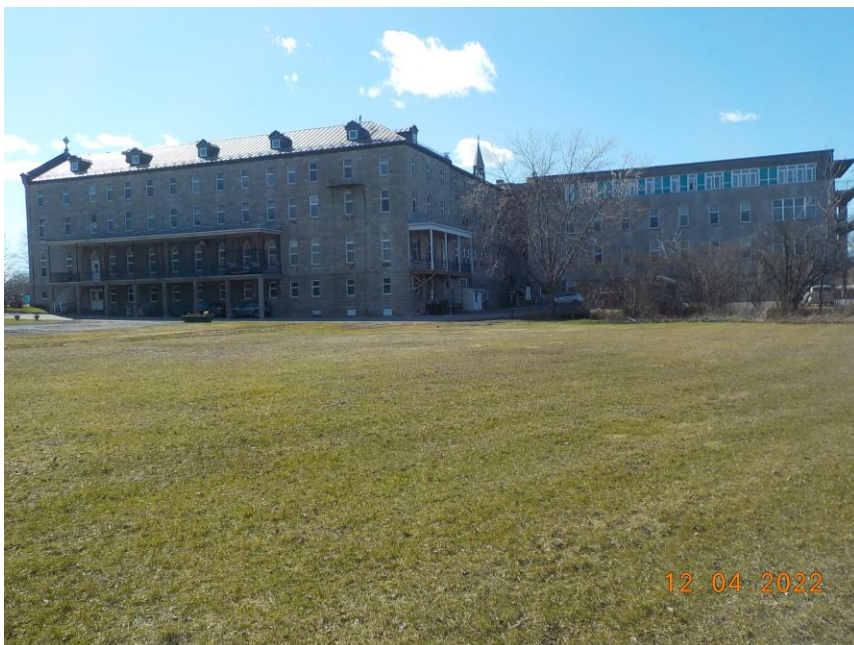
Photo 2 Vue générale de la façade est du bâtiment
