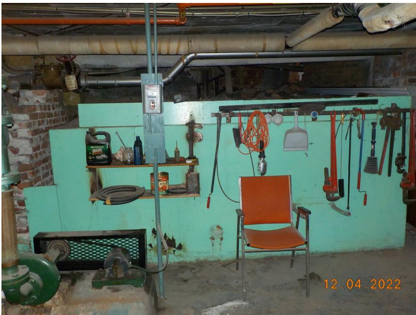
Photo 6 Vue de l'enclos des réservoirs souterrains enfouis dans le sable
