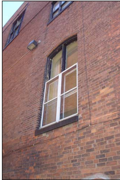
FIG 65 : Une des fenêtres arrière (C. Boucher, 2006)
