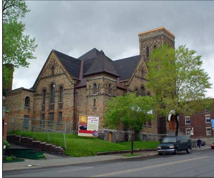
FIG 69 : L'ancienne Taylor Church (aujourd'hui Le Chemin du Paradis) avec ses jeux de brique particuliers (C. Boucher, 2006)
