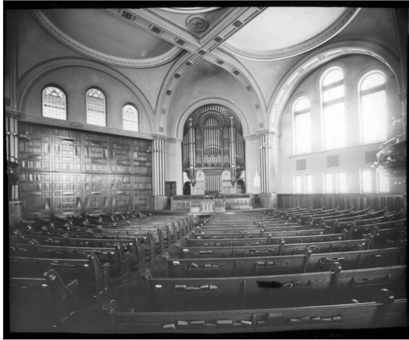
FIG 34 : Intérieur original de l'église Erskine (Archives nationales du Québec, fonds de l'Église Unie de Canada, P-603, S2, SS39)
