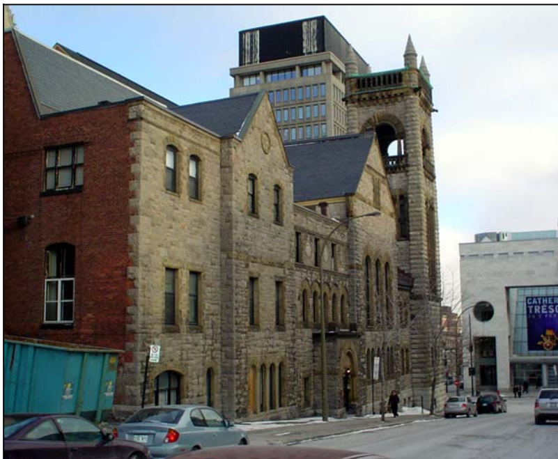
FIG 22 : Église Erskine and American, façade de l'avenue du Musée (C. Boucher, 2006)
