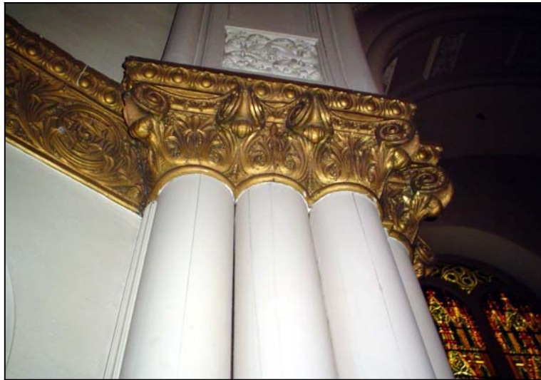
FIG 48 : Détails des chapiteaux des colonnes (C. Boucher, 2006)
