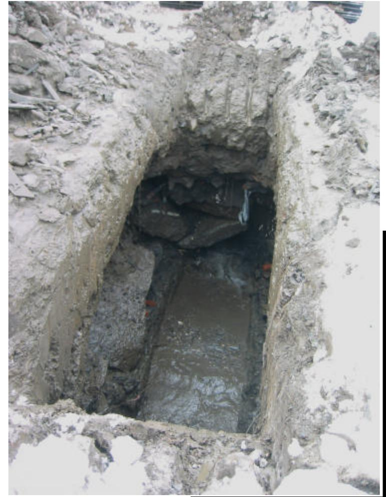
**Photo n° 10.**   →     Horizon de débris (90 %) composé majoritairement de gros blocs de béton,
