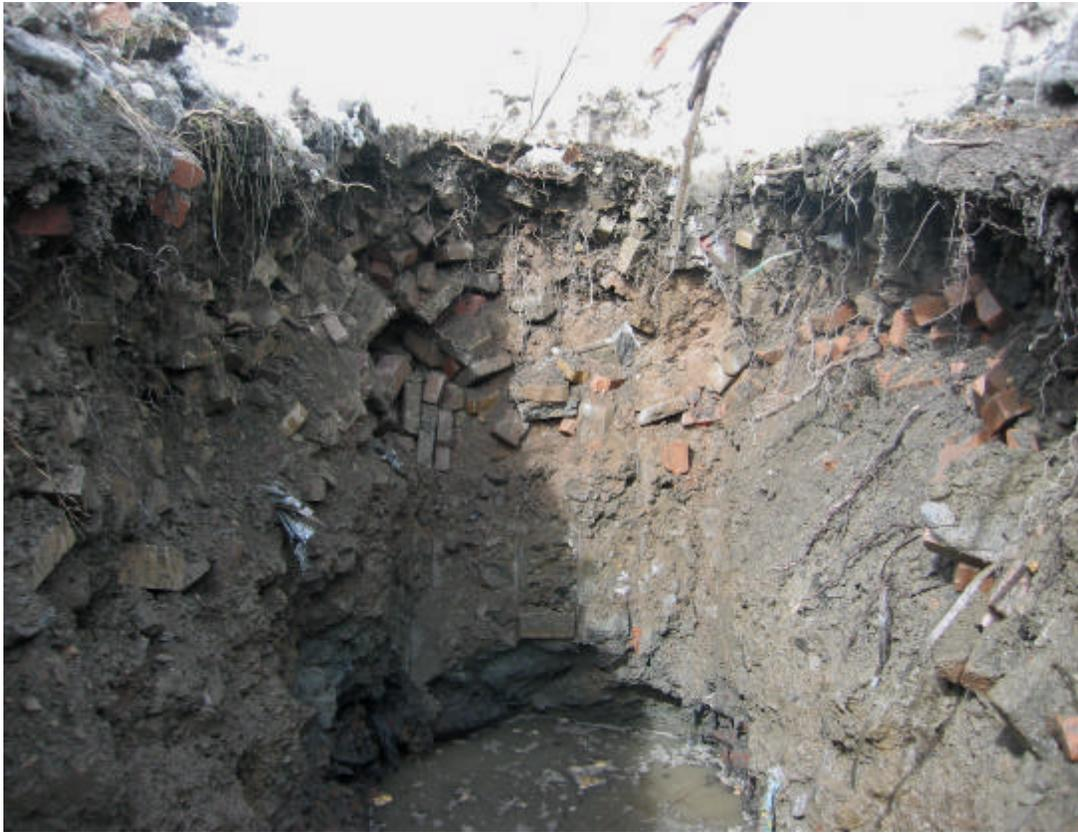
**Photo n° 9.**     ↑     Horizon avec débris (90 %) à la tranchée d'exploration TE-05-8.
